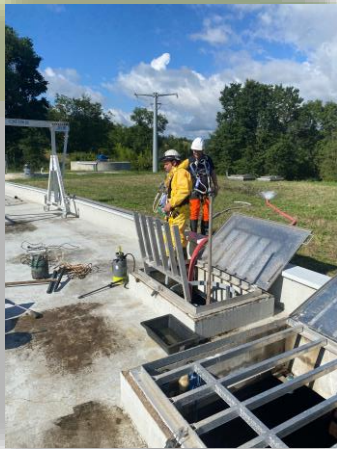
LAVAGE DE RESERVOIRS NETTOYAGE HP eau chaude
