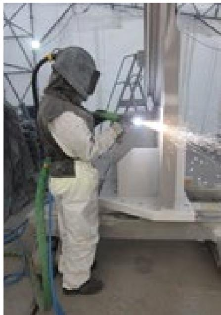
Photo 7 : Métallisation à l'arc électrique © Lassarat
