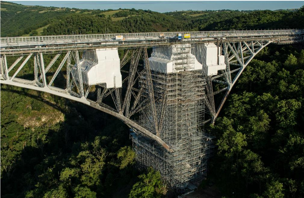
**Photo 18 : Viaduc du Viaur en cours de travaux ; il est important de noter la juste répartition des échafaudages et confinements de chaque côté de la pile afin de respecter les charges admissibles et l'équilibre de l'ouvrage en phase travaux © Lassarat**
