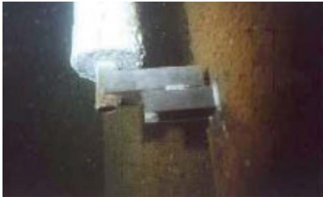
*Photo 3 : Anode extérieure sur un pieu métallique © Grimaldi*
