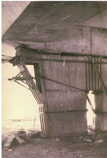
Figure 38 : Disposition d'appui hors structure existante à droite ou par brélage sur l'appui à gauche
