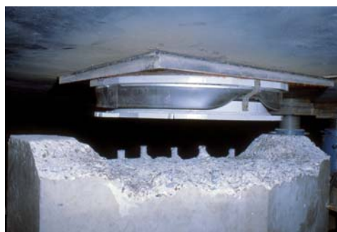
Figure 48 : (à gauche) L'appareil d'appui (ici un appareil d'appui à pot) est fixé à l'intrados de la structure et le coffrage du bossage inférieur va être mis en place. (à droite) Le principe du débullage. Crédit photo Y. PICARD
