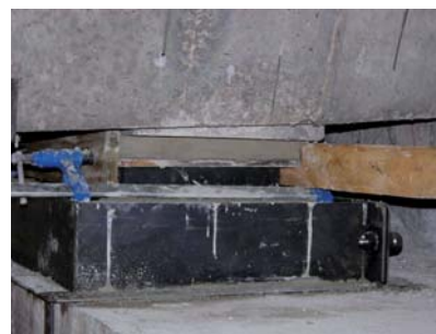
Document SETRA/LCPC (référence § 1.2.4) Crédit photo P. DANTEC - LRPC de Clermont Ferrand Figure 49 : Disposition type pour la réalisation d'un matage, à gauche. Réalisation sur un chantier, à droite.
