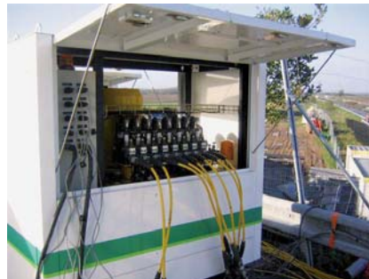
b) Groupe électrogène couplé avec les pompes et les électrovannes. Crédit photo GTM Travaux Spéciaux
