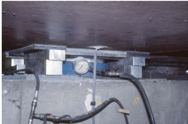
Figure 19 : Un exemple de vérin à piston plat. A noter le calage de sécurité par cales biaisées en alliage d'aluminium. Crédit photo Y. PICARD
