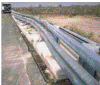
Figure 26 : Au cours d'un choc, la longrine non ancrée peut, notamment pour les longrines sous barrières de niveau H (portant des BHO ou des BN5), être soit déplacée, soit cassée. Crédit photo SETRA/CTOA
