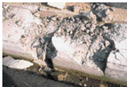
Figure 26 : Au cours d'un choc, la longrine non ancrée peut, notamment pour les longrines sous barrières de niveau H (portant des BHO ou des BN5), être soit déplacée, soit cassée. Crédit photo SETRA/CTOA
