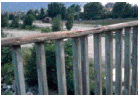
Figures 9 : corrosion «avancée» d'un garde-corps pouvant diminuer sa résistance. (Crédit photos SETRA/CTOA)
