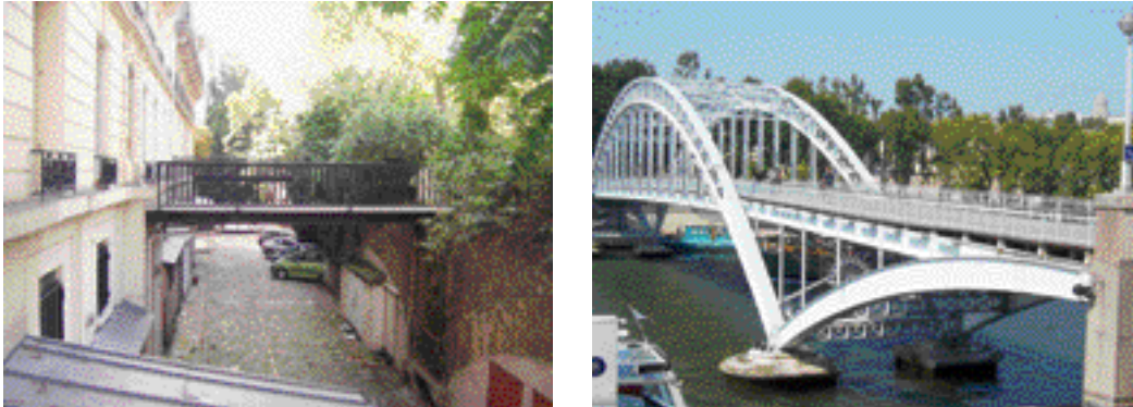
Figures 6 et 7: exemples de GC sur une passerelle dans un domaine de bâtiment (à gauche) et dans un contexte de génie civil (à droite). Crédit photos M. Fragnet
