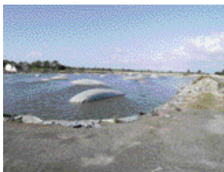
d) Gonfles par gaz de fermentation du sol support
