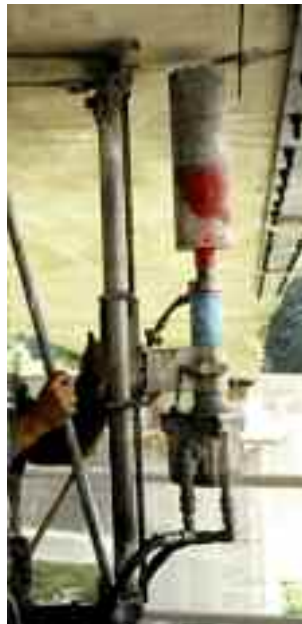
Photo n° 84 : carottage aux 4 coins avant sciage (crédit photo D. Poineau)
