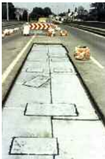
Photo n° 108 : réparation de la chape d'étanchéité (crédit photo LRPC)
