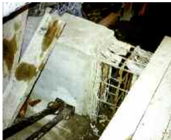
Photo n° 89 : joint de retrait au viaduc d'Oléron (crédit photo D. Poineau)
