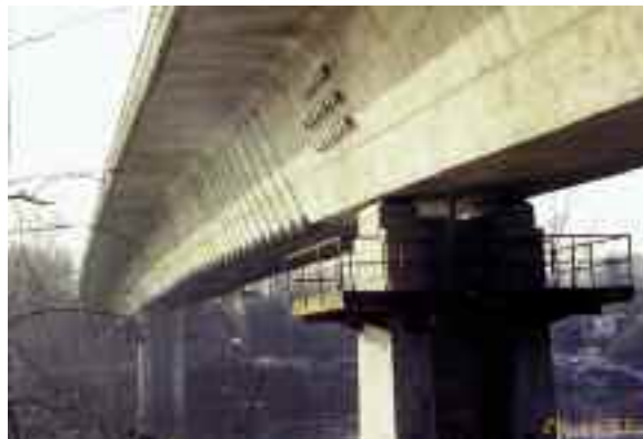
Photo n° 52 : corsets précontraints du pont de Champigny-sur-Yonne (crédit photo D. Poineau)
