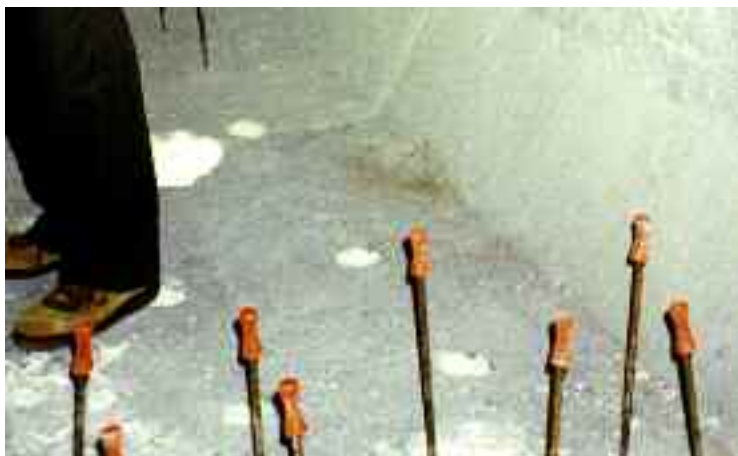
Photo n° 82 : embouts de protection des barres en attente (crédit photo D. Poinneau)
