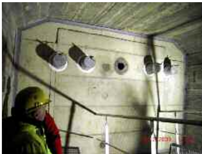
Photo n° 38 : entretoise d'ancrage en BAP du pont de Verberie sur l'autoroute A1 (crédit photo D. Poineau)
