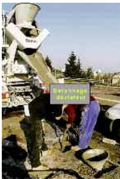
Photo n° 91 : bétonnage en cours depuis la surface du tablier (crédit photo Sétra)
