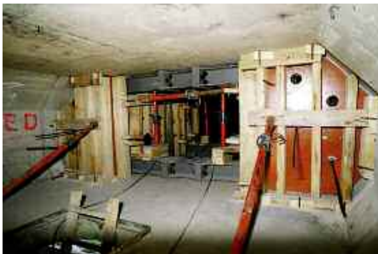
Photo n° 90 : coffrages en place juste avant le bétonnage par des ouvertures pratiquées dans le hourdis supérieur (crédit photo Sétra)
