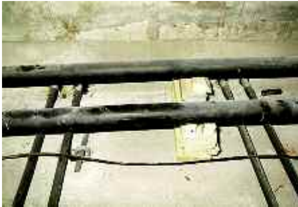
Photo n° 109 : croisement des précontraintes additionnelles longitudinale et transversale (crédit photo Sétra)
