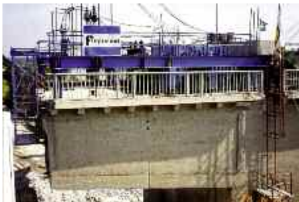
Photo n° 146 : équipage mobile de déconstruction (crédit photo D. Poineau)
