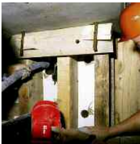
Photo n° 94 : vibration en cours par les fenêtres prévues dans les coffrages (crédit photo Sétra)
