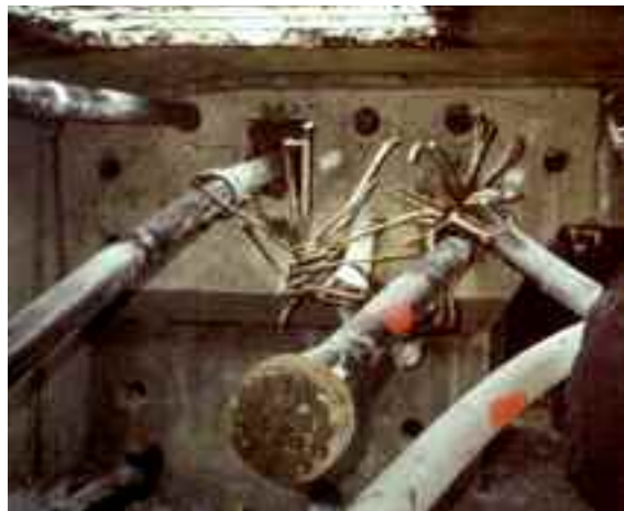
Photo n° 142 : ancrages ayant giclés hors de leur trompette d'ancrage (crédit photo D. Poineau)
