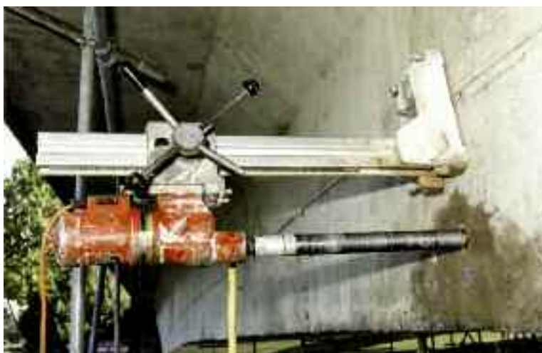
Photo n° 83 : carottage en cours pour le passage de monotorons de la précontrainte transversale (crédit photo Sétra)
