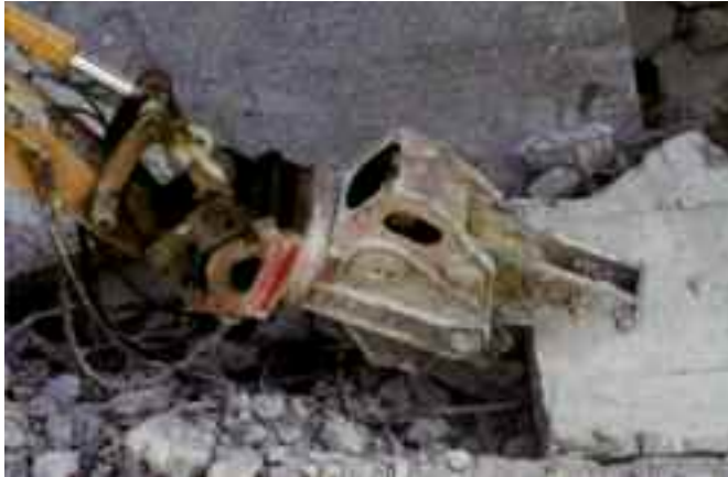
Photo n° 148 : destruction d'un voussoir à la pince à béton (crédit photo D. Poineau)
