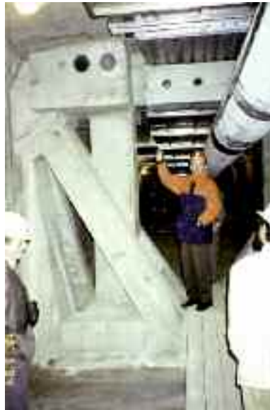
Photo n° 99 : déviateur au viaduc d'Oléron (crédit photo D. Poineau)
