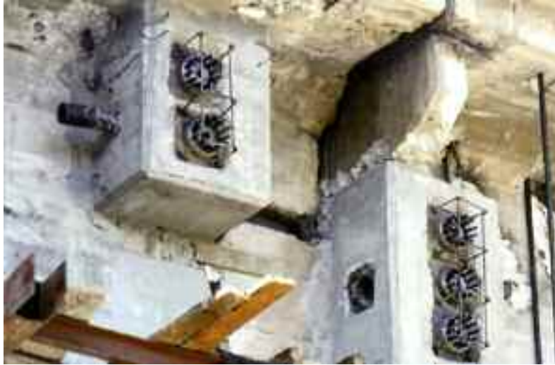
Photo n° 25 : massifs d'ancrage d'une précontrainte transversale additionnelle rectiligne (crédit photo Freyssinet)
