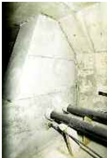
Photo n° 98 : déviateur terminé et supports provisoire des conduits (crédit photo Sêtra)
