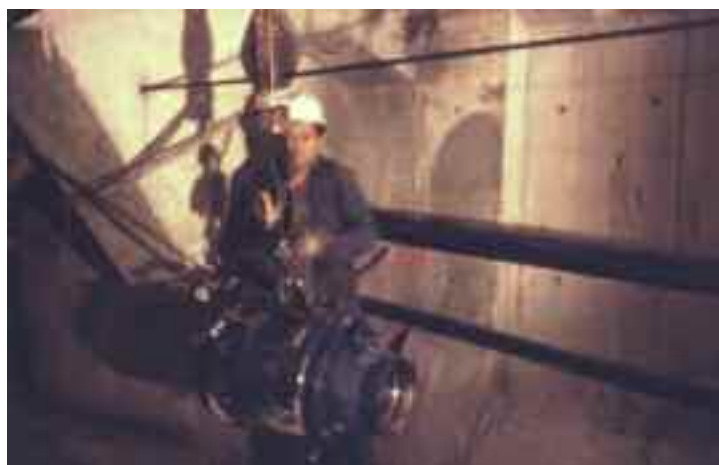
Photo n° 131 : manutention d'un vérin lors des réparations du viaduc des Canadiens sur l'Autoroute A 4 près de Paris (crédit photo D. Poineau)
