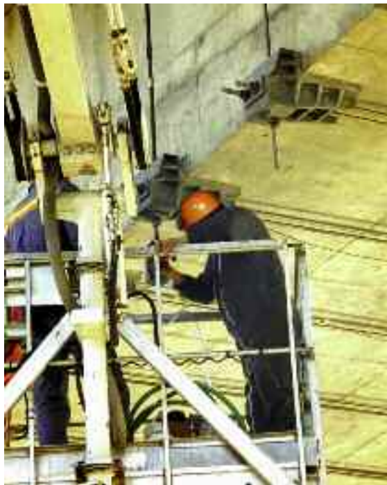
Photo n° 149 : contrôle en cours de la tension sur des barres en acier inoxydable lors des réparations du pont de Labéraudie (crédit photo D. Poineau)
