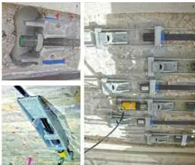
Figure n° 57 : système de précontrainte à base de matériaux composites (crédit photo Sika-France)
