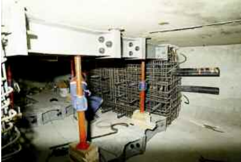
Photo n° 88 : ferrailage du massif d'ancrage terminé avec ses tirants-butons (crédit photo Séttra)
