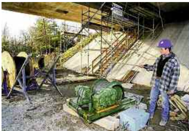
Photo n° 115 : dispositif d'enfilage à l'extérieur du tablier (crédit photo Sétra)
