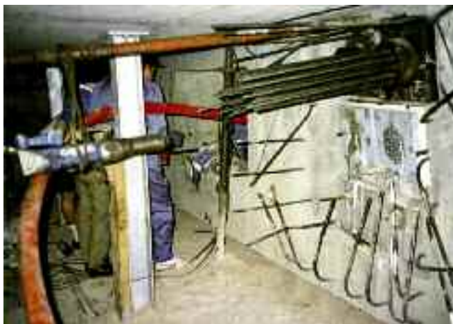
Photo n° 132 : mise en tension de monotorons gainés-protégés lors des réparations du pont de Corbeil (crédit photo D. Poinneau)
