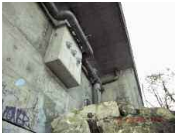
Photo n° 97 : armatures de clouage du serrage d'un massif d'ancrage au pont de Verberie 21 (crédit photo D. Poineau)
