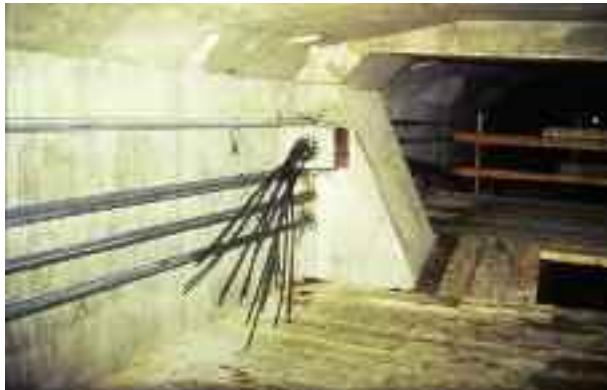
Photo n° 60 : armatures galvanisées provisoires du viaduc du Magnan (crédit photo LRPC)
