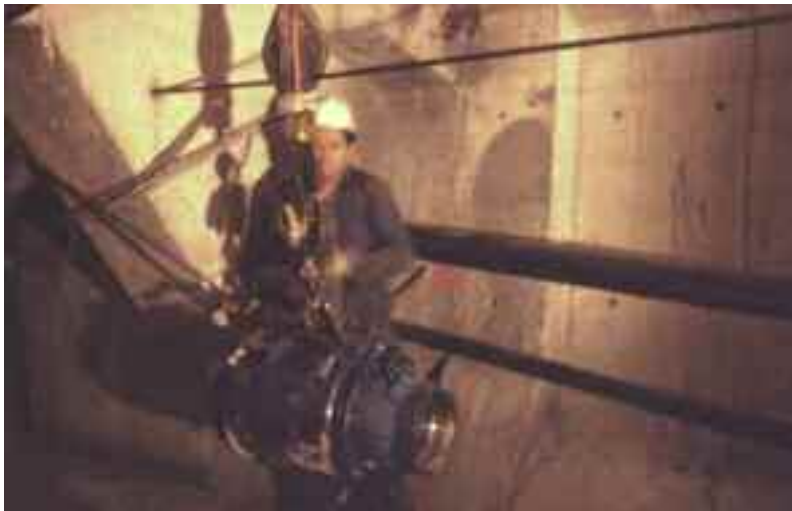
Photo n° 26 : transport d'un vérin au viaduc des Canadiens (crédit photo D. Poineau)
