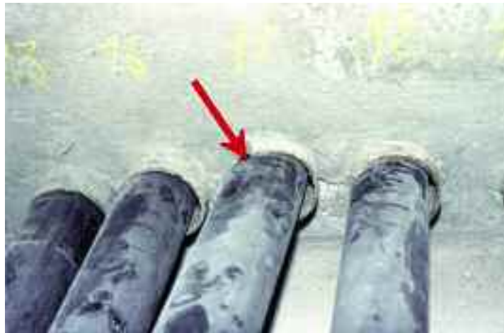
Photo n° 46 : pincement de la gaine à la sortie d'un tube déviateur (crédit photo D. Poineau)
