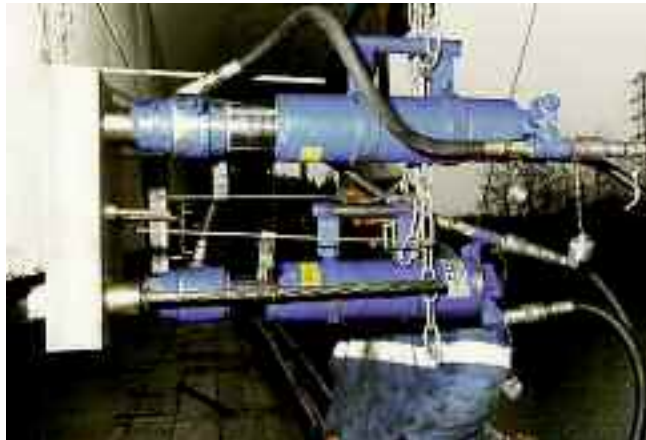
Photo n° 111 : mise en tension des monotorons par couple de deux (crédit photo Séttra)
