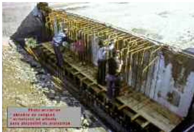
Photo n° 32 : préparation du ferrailage du massif d'ancrage du pont de Lacroix-Falgarde (crédit photo D. Poinéau)
