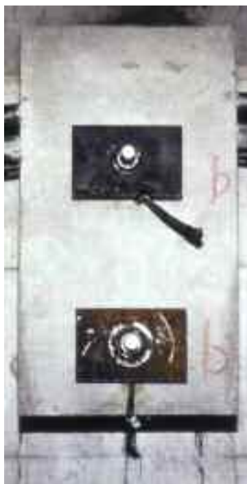
Photo n° 100 : déviateur préfabriqué en béton (crédit photo LRPC)
