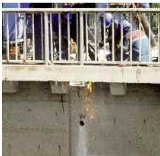
Photo n° 147 : découpe des câbles de fléau (crédit photo D. Poineau)
