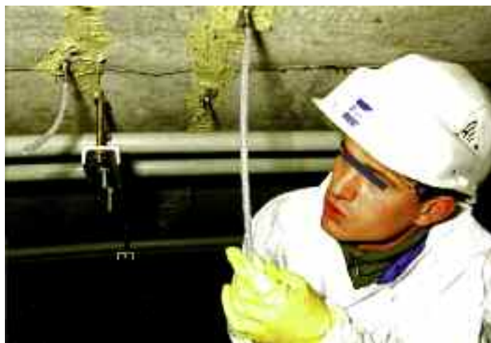
Photo n° 128 : injection en cours (crédit photo Sétra)
