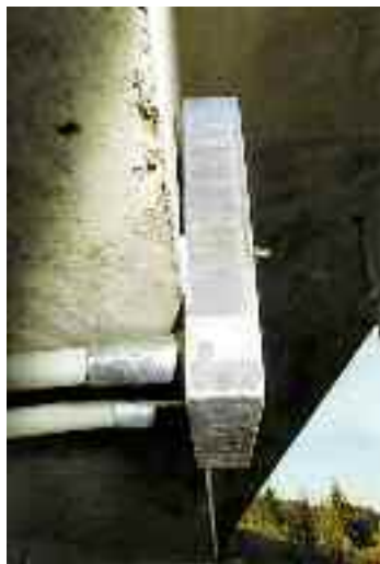
Photo n° 110 : début de la mise en place d'une plaque de répartition avec sa bande résiliente (crédit photo Sétra)
