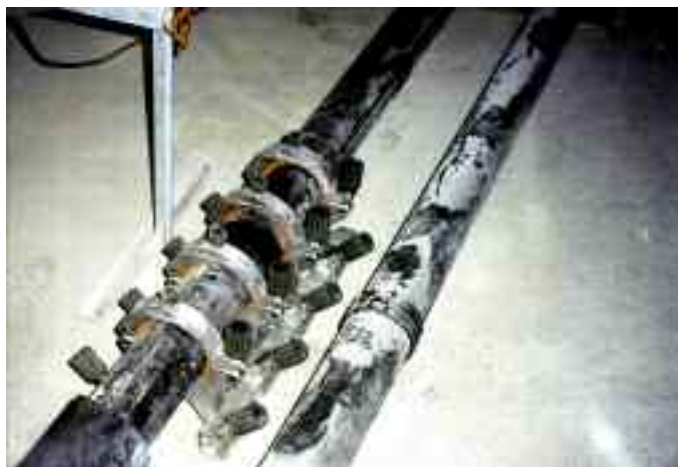
Photo n° 72 : mise en œuvre de manchons thermo-soudables (crédit photo D. Poineau)
