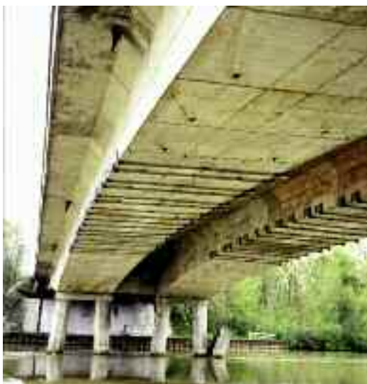
Photo n° 112 : précontrainte transversale du hourdis inférieur terminée au pont de Châlons-en-Champagne (crédit photo Séttra)
