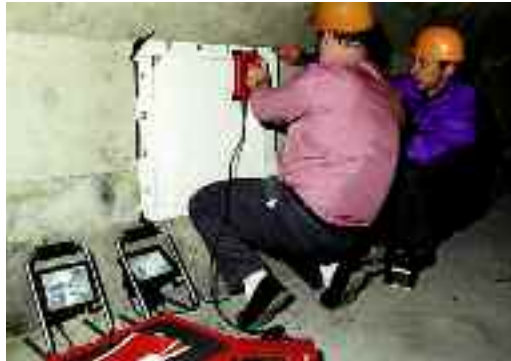
Photo n° 80: repérage des armatures passives au pachomètre (crédit photo Sétra)
