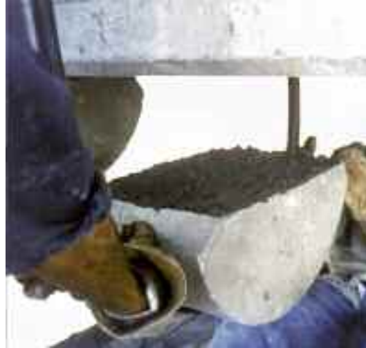
Photo n° 105 : mise en place d'une pièce de déviation sous le talon d'une poutre (crédit photo Freyssinet)
