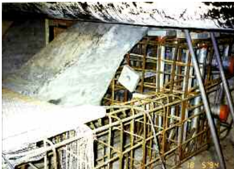
Photo n° 78 : exemple d'accès difficile : création d'un déviateur entre une canalisation et une entretoise d'appui en treillis au viaduc d'Oléron (crédit photo D. Poineau)
