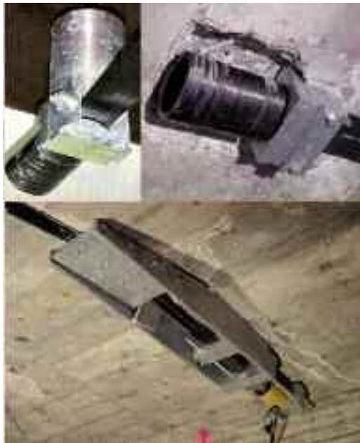
Photo n° 74 : ancrage fixe et mobile de bandes de matériaux composites tendues (crédit photo Sika-Suisse)
