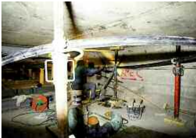
Photo n° 116 : dispositif d'enfilage à l'intérieur du tablier (crédit photo Sétra)
