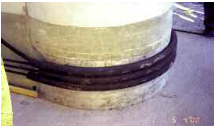
Photo n° 28 : essai de conformance de réalisation d'un câblage bouclé au pont d'Agde (crédit photo D. Poineau)
