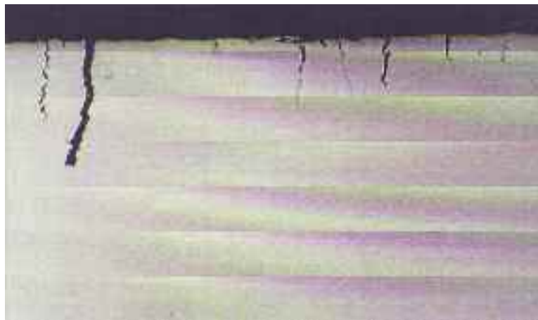
Photo n° 18 : fissures de corrosion sous tension sur le fil d'un toron (photo LRPC de l'Est Parisien)
