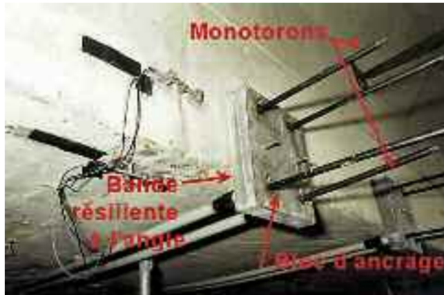
Photo n° 20 : ancrages de précontrainte additionnelle transversale avant capotage (crédit photo Sétra)
