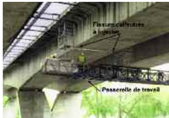
Photo n° 126 : travaux d'injection en cours (crédit photo Parexlanko)
