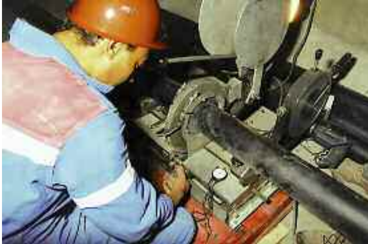
Photo n° 71 : soudure au miroir au pont de Châlons-en-Champagne (crédit photo Sétra)
