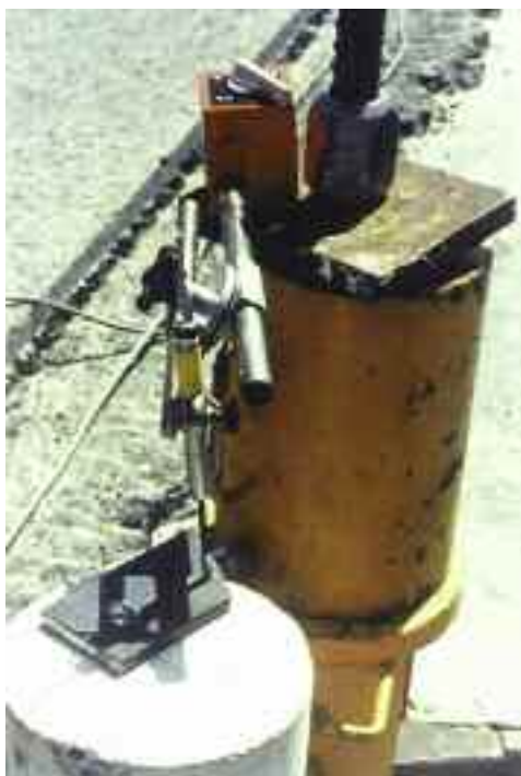
Photo n° 106 : mise en tension d'une barre nervurée avec enregistrement de la pression au vérin et des allongements (crédit photo LAPC)
