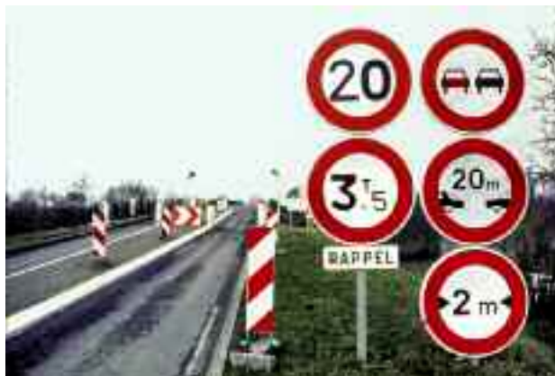
Photo n° 79 : signalisation et gabarit en largeur pour empêcher le passage des poids lourds sur le pont durant les travaux de réparation (crédit photo D. Poinneau)
