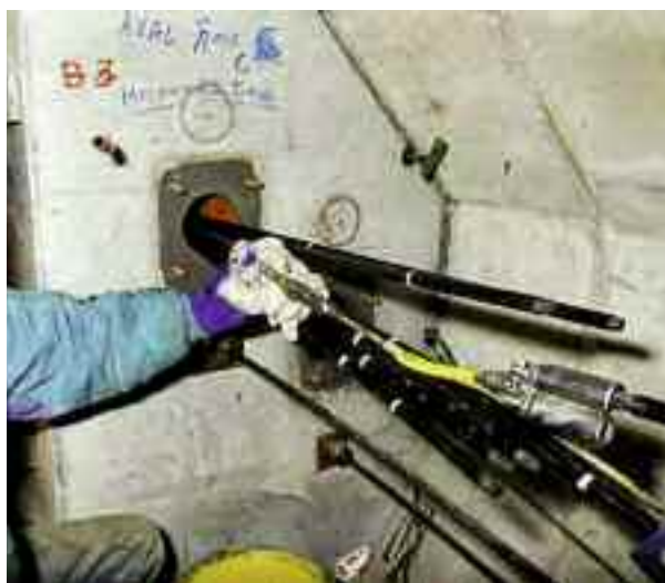
Photo n° 117 : détail de l'enfilage du monotoron gainé-protégé dans l'ancrage et le conduit (crédit photo Sétra)
