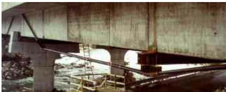
Photo n° 144 : renforcement provisoire du viaduc de Val Durance par une précontrainte extérieure (crédit photo D. Poineau)
