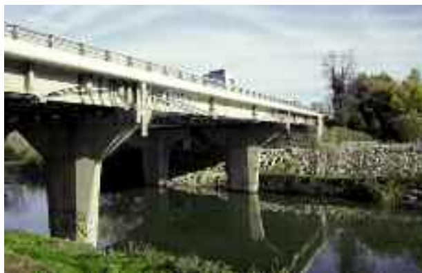
Photo n° 31 : renforcement d'un VIPP du réseau ASF (crédit photo Sylvain Lopez)
