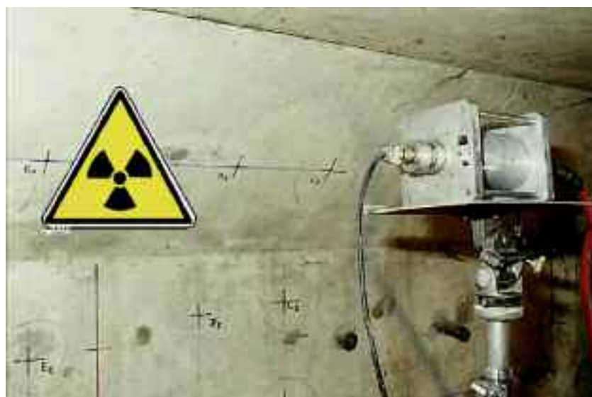
Photo n° 81 : source radioactive à l'intérieur d'une poutre-caisson (crédit photo Sétra)
