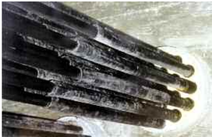
Photo n° 122 : détail du déviateur «barillet» et des gainettes de protection en PEHD (crédit photo D. Poinéau)
