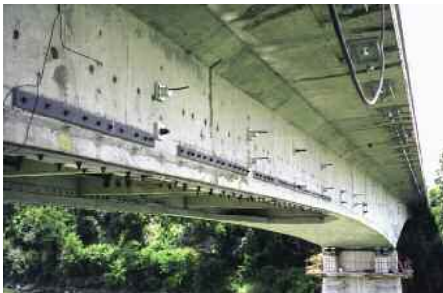
Photo n° 55: vue des réparations du pont de Blagnac (crédit photo D. Poineau)
