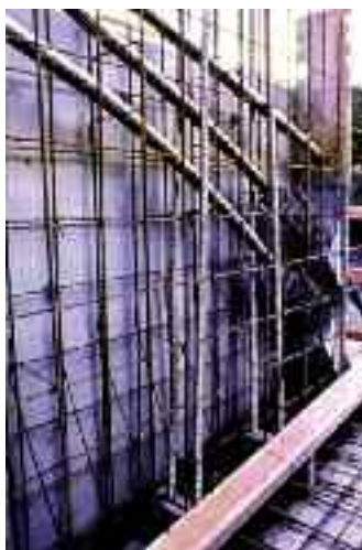
Photo n° 16 : utilisation d'étriers actifs pour équilibrer les efforts de diffusion (crédit photo D. Poineau)
