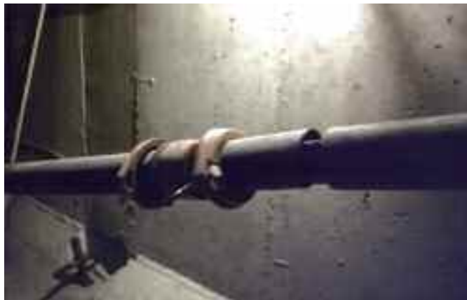
Photo n° 68 : raccord entre deux tronçons d'un conduit au viaduc des Canadiens (crédit photo D. Poinneau)
