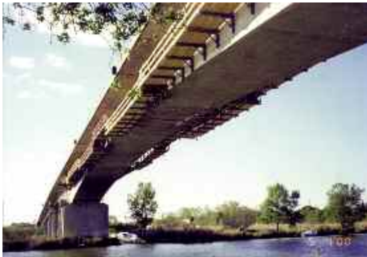
Photo n° 75 : dispositif d'accès aux faces latérales du pont d'Agde (crédit photo D. Poineau)
