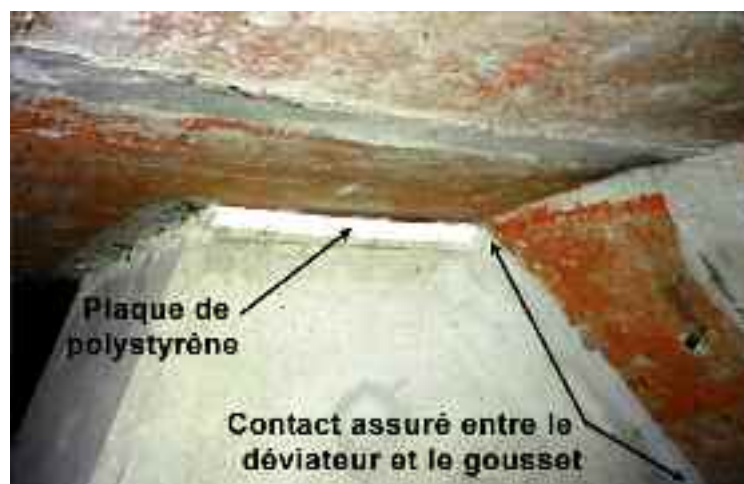
Photo n° 37 : couche résiliente en partie haute d'un déviateur (crédit photo Sétra)
