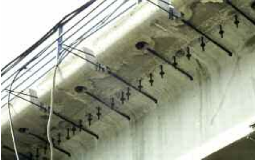
Photo n° 47 : précontrainte transversale additionnelle du viaduc de Pré-Claou (crédit photo D. Poineau)
