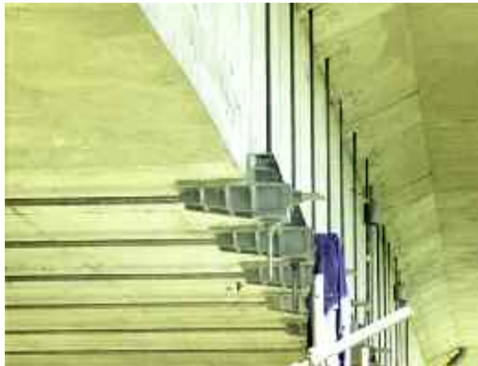
Photo n° 49 : étriers actifs du pont de Labéraudie (crédit photo D. Poinneau)
