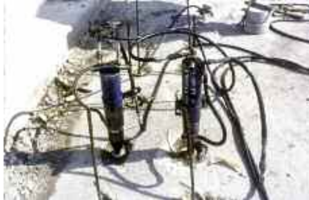
Photo n° 107 : mise en tension d'étriers à base de monotorons gainés-protégés (crédit photo Freyssinet)
