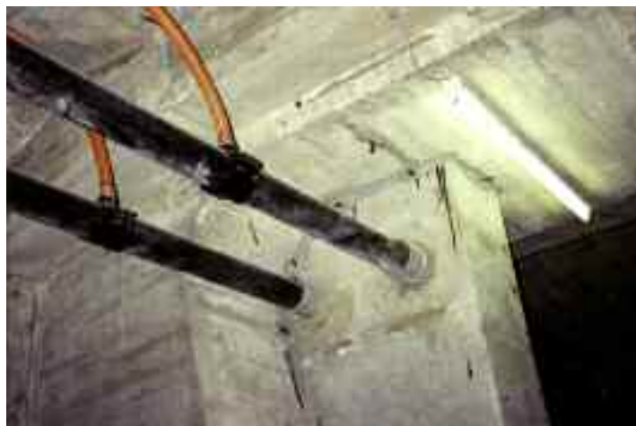
Photo n° 93 : dispositif d'injection d'une reprise de bétonnage (crédit photo D. Poineau)
