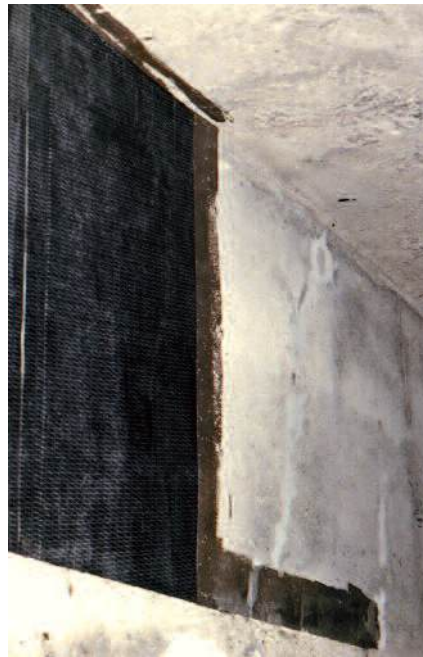
Photo n° 32 : tissu composite en cours de collage sur les âmes des poutres (crédit photo D. Poinéau)
