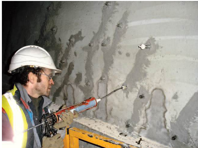
Photo n° 28 : injection des fissures (crédit photo VSL France)
