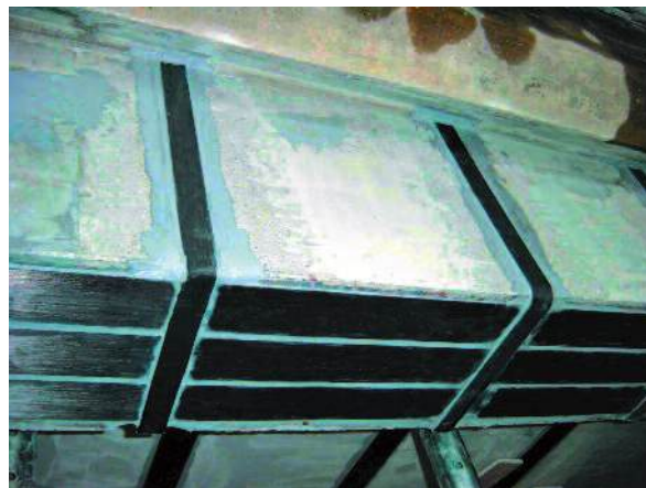
Photo n° 42 : système «Sika Carboshear L» en place (crédit photo Sika)
