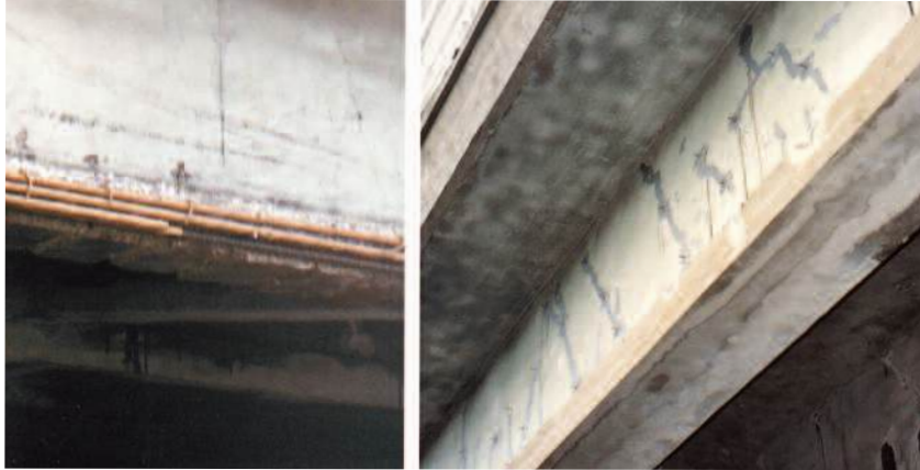
Photo n° 29 : reconstitution du ferrailage et de la géométrie des talons endommagés (crédit photo D. Poineau)
