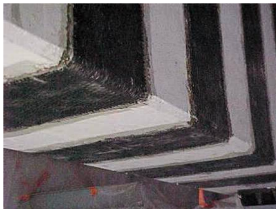
Photo n° 43 : renforcement vis-à-vis de l'effort tranchant (crédit photo Freyssinet)
