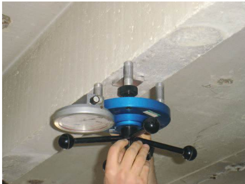
Photo n° 54 : essai de traction de surface (crédit photo VSL France)
