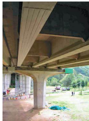
Photo n° 36 : renfort des poutres de rive intérieures (crédit photo SIKA)
