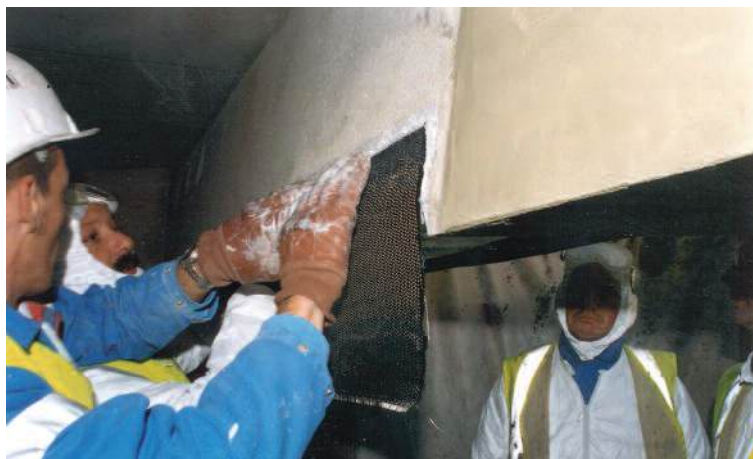
Photo n° 49 : pose de tissu en matériau composite (crédit photo Freyssinet)
