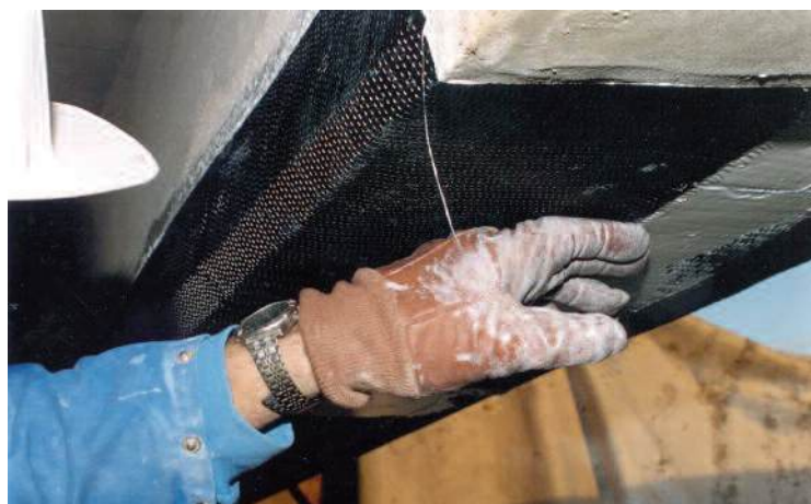
Photo n° 50 : suite de la pose d'un tissu en matériaux composites (crédit photo Freyssinet)
