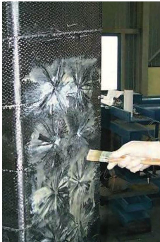
Photo n° 41 : phase 2 de la pose d'une mèche d'ancrage (crédit photo Freyssinet)
