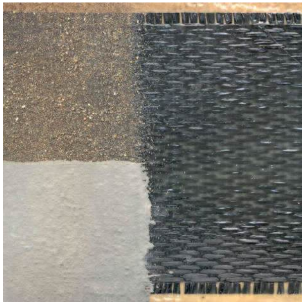
Photo n° 53 : tissu composite brut de pose - tissu composite après application d'une résine sablée revêtement de protection sur la résine sablée (crédit photo Freyssinet)
