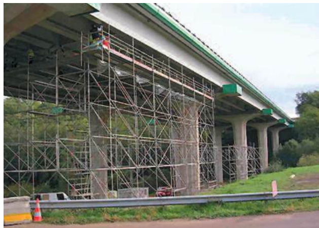
Photo n° 34 : vue générale du chantier (crédit photo SIKA)
