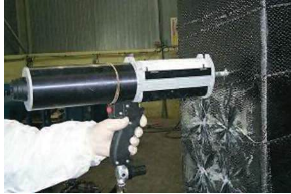
Photo n° 40 : phase 1 de la pose d'une mèche d'ancrage (crédit photo Freyssinet)
