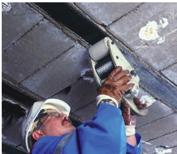
Photo n° 45 : pose de bandes de tissu sec avec un appareil dérouleur de bandes (crédit photo Freyssinet)
