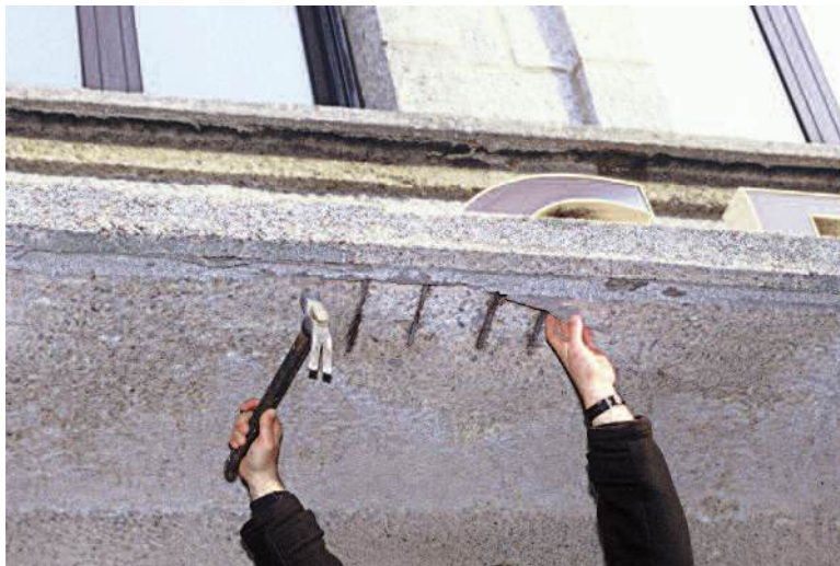
Photo n° 15 : sondage au marteau (crédit photo Parexlanko)
