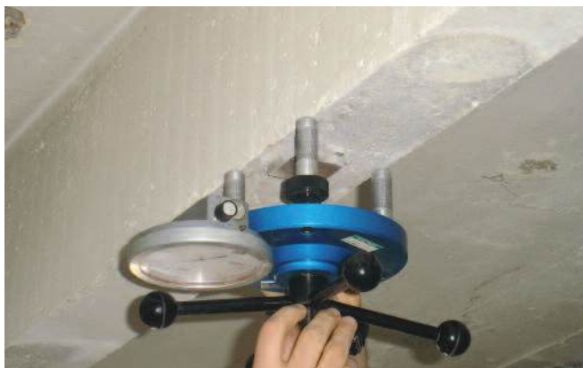
Photo n° 16 : essai de traction de surface (crédit photo VSL France)
