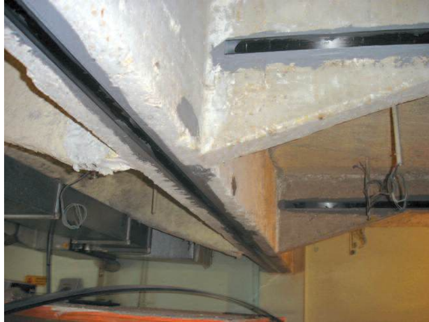
Photo n° 25 : lamelles de renfort sous les talons et les faces latérales de poutres (crédit photo VSL France)
