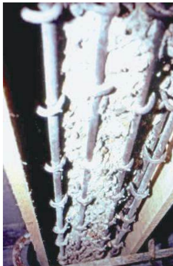
Photo n° 8 : préparation du support béton et des armatures au pont de Limay (crédit photo D. Poineau)
