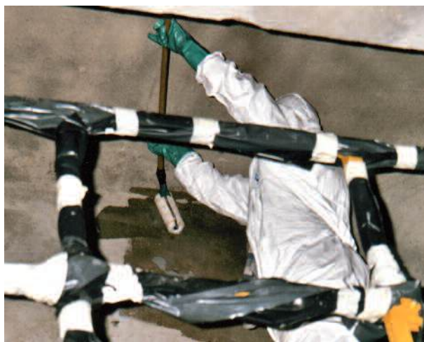
Photo n° 48 : encollage du support béton – Renforcement du pont sur le CD 126 à Arcueil (crédit photo D. Poinneau)
