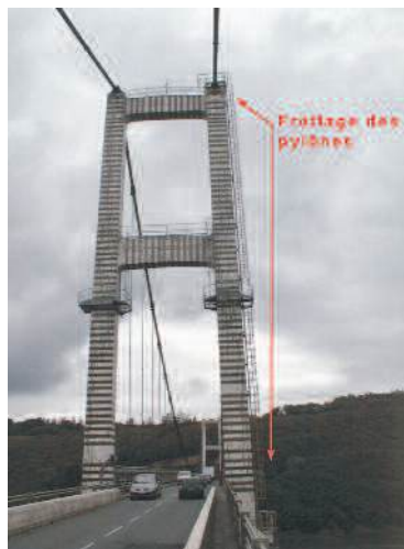
Photo n° 39 : frettage des pylônes du pont de Térénez par des bandes de matériaux composites collés (crédit photo Freyssinet)
