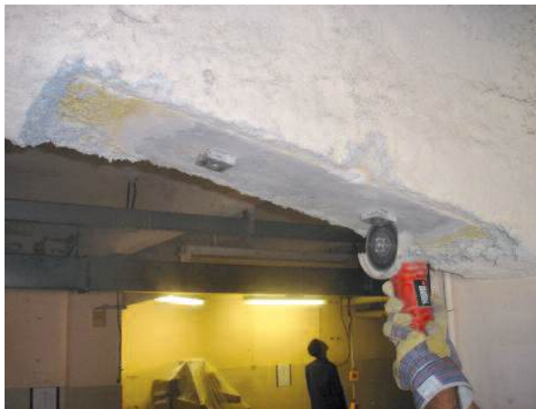
Photo n° 22 : dégagement du flocage de protection contre l'incendie des poutres (crédit photo VSL France)
