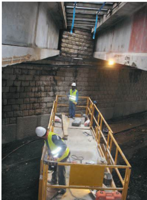
Photo n° 30 : enlèvement du béton désorganisé et décapage des armatures corrodées (crédit photo VSL France)
