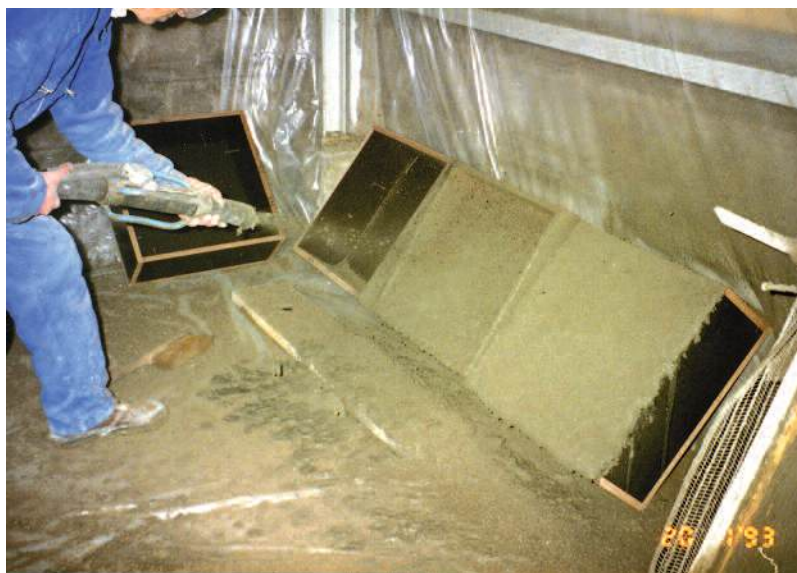
Photo n° 18 : projection dans une boîte pour essais sur éprouvettes carottées (crédit photo D. Poineau)
