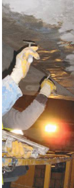
Photo n° 31 : ragréage en cours (crédit photo VSL France)
