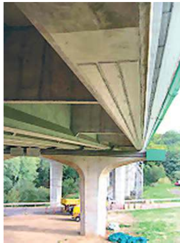
Photo n° 35 : renfort des poutres de rive extérieures (crédit photo SIKA)
