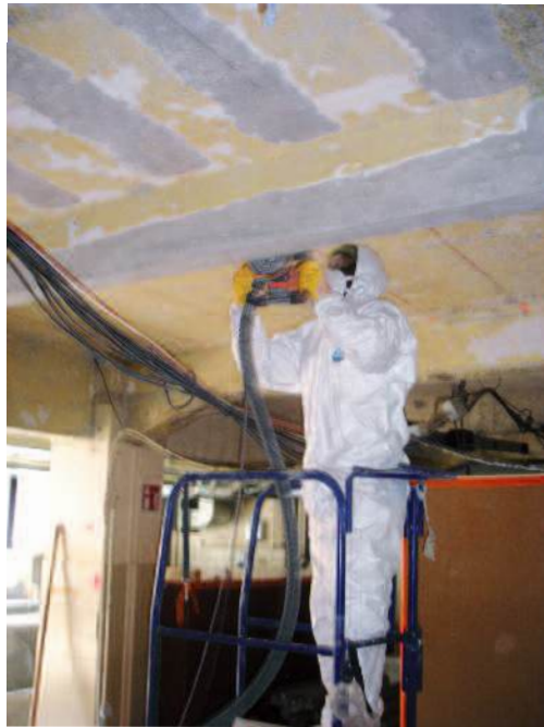
Photo n° 24 : ponçage des talons et des faces latérales des poutres ainsi que de l'intrados des dalles (crédit photo VSL France)
