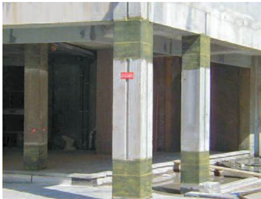
Photo n° 38 : frettage de poteaux par composites (crédit photo Freyssinet)
