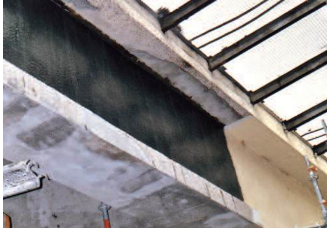
Photo n° 33 : réalisation du revêtement de protection du tissu composite (crédit photo D. Poineau)
