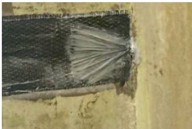
Photo n° 52 : mèche en place (crédit photo Freyssinet)
