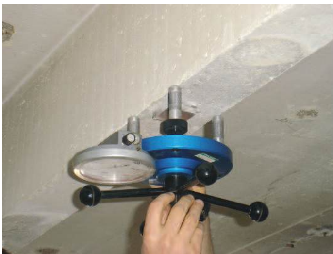
Photo n° 46 : mesure de la cohésion de la surface du béton avec une pastille carrée (crédit photo VSL France)
