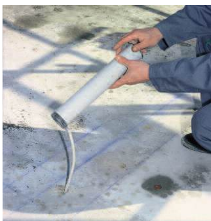
Photo n° 11 : remplissage des trous avant scellement de barres (crédit photo Parexlanko)
