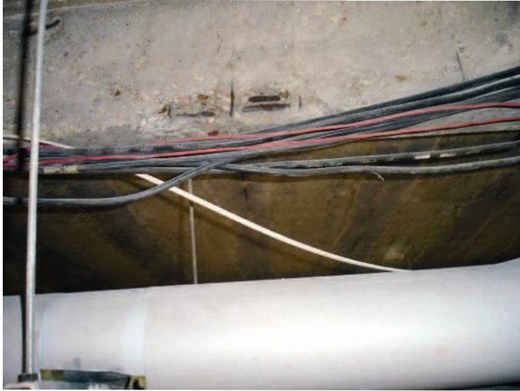
Photo n° 23 : début de la préparation de l'intrados et des deux faces latérales des poutres (crédit photo VSL France)
