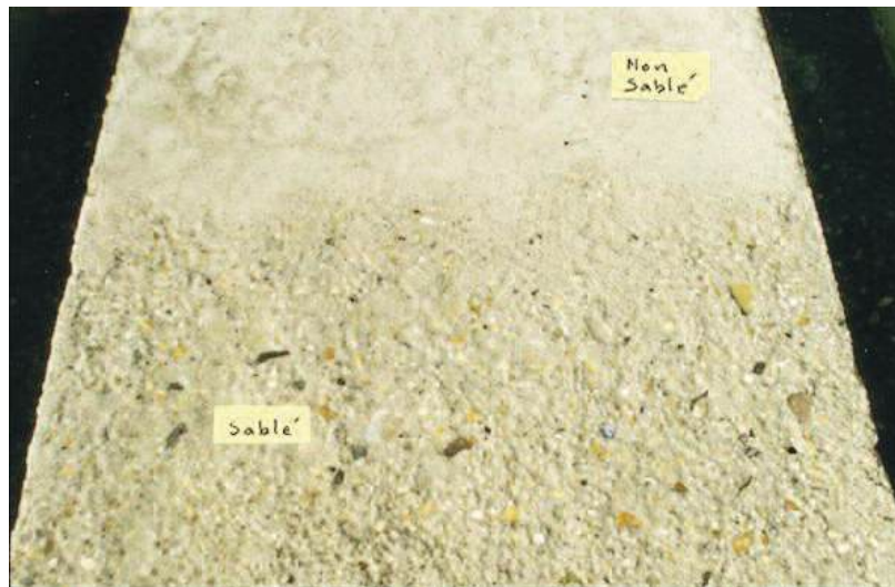
Photo n° 47 : intrados d'une poutre avant et après sablage (crédit photo Freyssinet)
