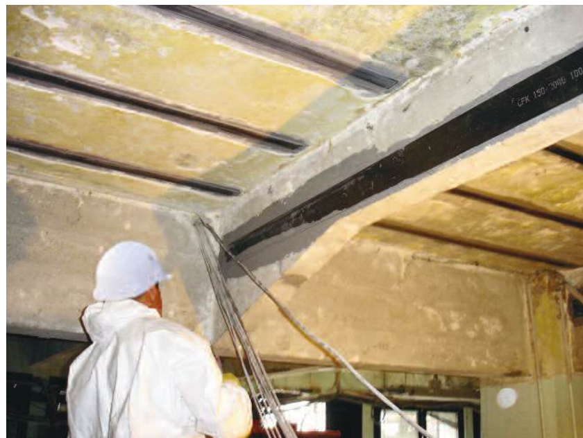
Photo n° 26 : renforts en place des poutres et des dalles (crédit photo VSL France)
