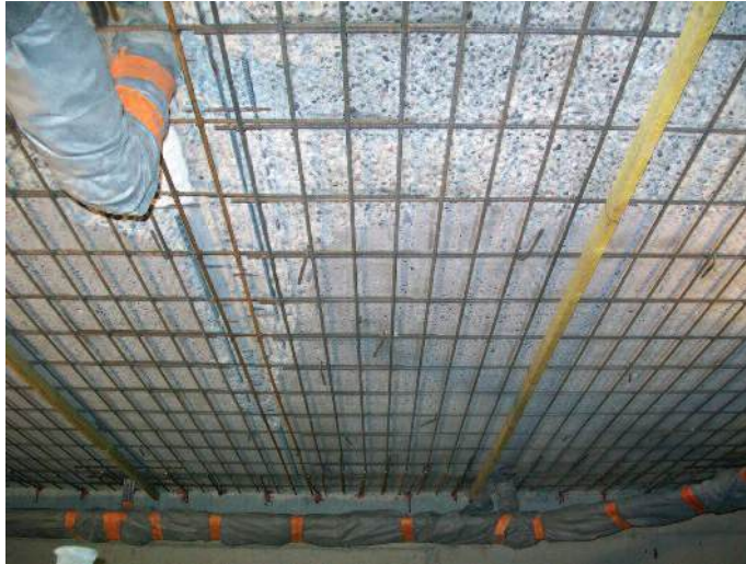
Photo n° 7 : renforcement en sous-face d'une dalle avec connecteurs scellés (crédit photo Freyssinet)
