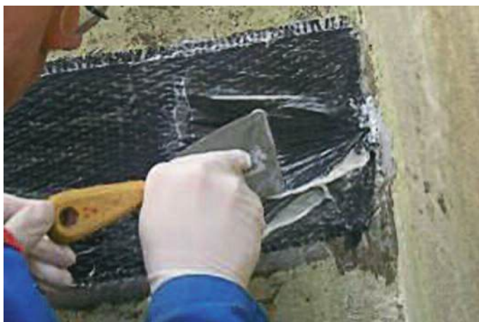
Photo n° 51 : collage d'une mèche sur une bande de tissus (crédit photo Freyssinet)
