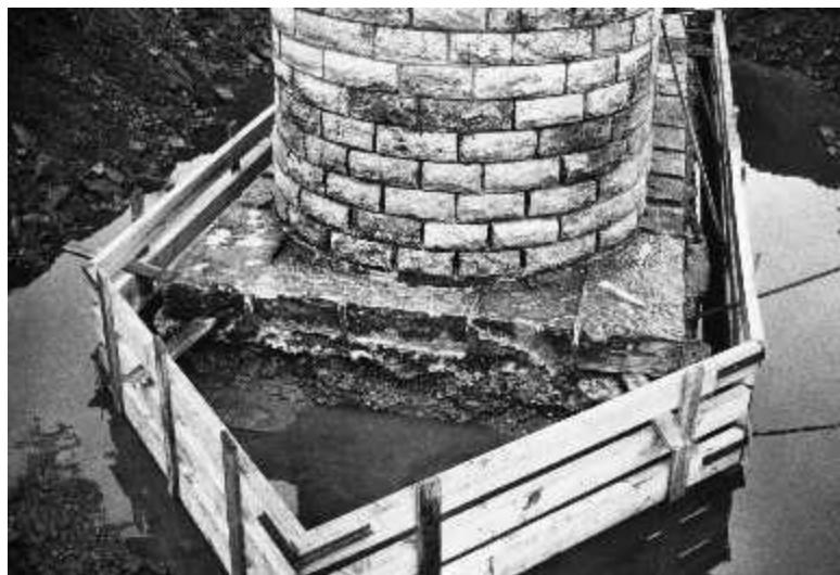
Photo n° 17 : coffrage d'un corset en béton armé (crédit photo JP. Levillain)
