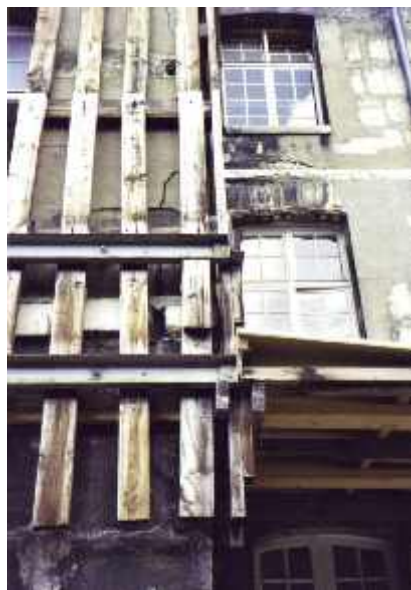
Photo n° 35 : réparation provisoire d'un bâtiment au Kremlin-Bicêtre (crédit photo D. Poinéau)
