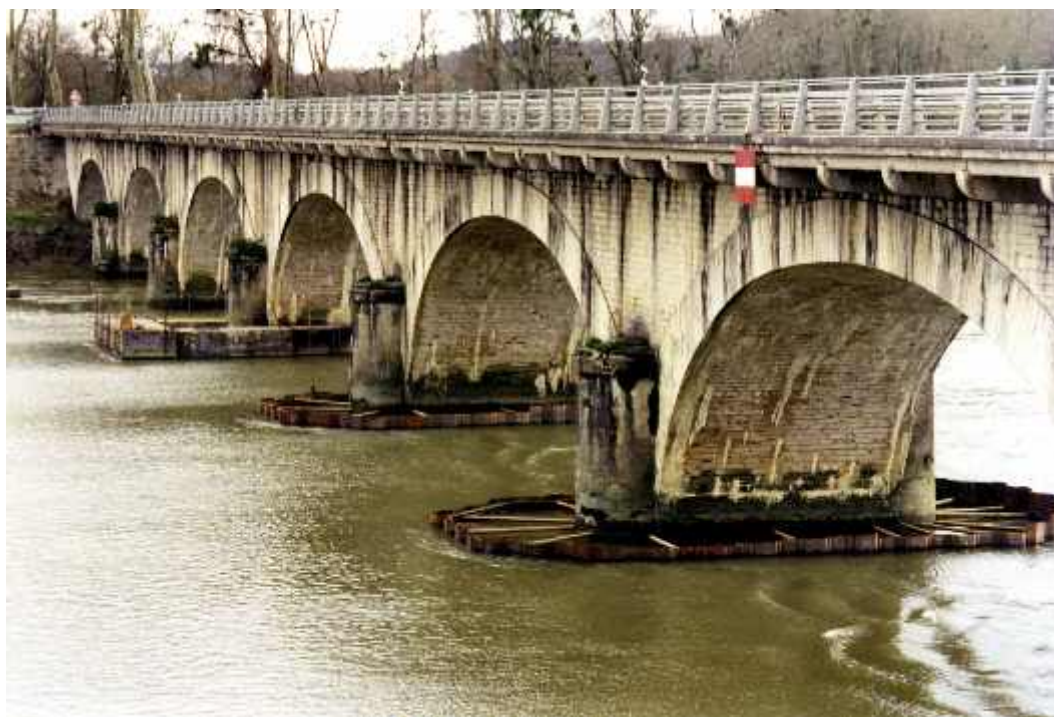
Photo n° 14 : exemple de protection des sols au pourtour des appuis par un rideau de palplanches (crédit photo JP. Levillain)
