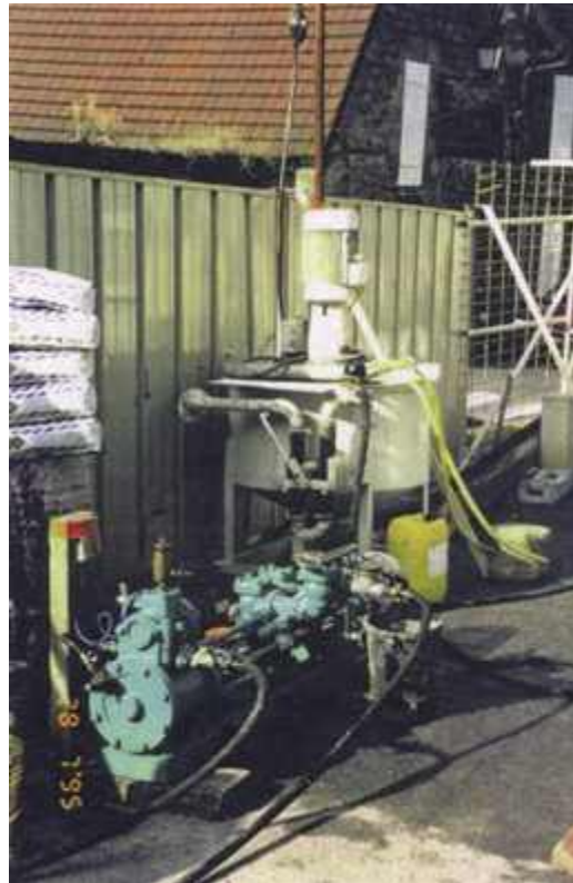
Photo n° 23 : centrale d'injection (crédit photo A. Bouineau)
