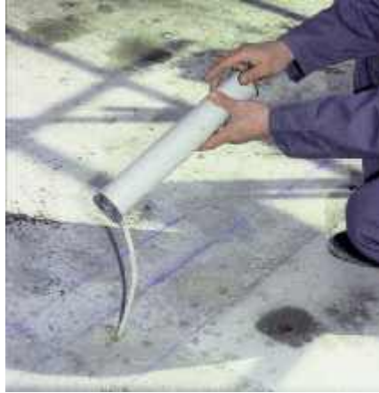
Photo n° 56 : remplissage des trous avant scellement de barres (crédit photo Parexlanko)
