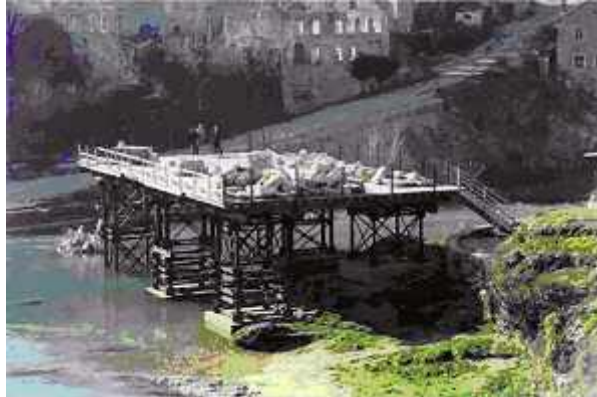
Photo n° 5 : stockage des pierres récupérées après la destruction du pont de Mostar (crédit photo A. Bouineau)
