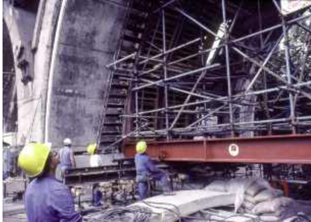
Photo n° 71 : déplacement de la contre-voûte préfabriquée (crédit photo D. Poinéau)
