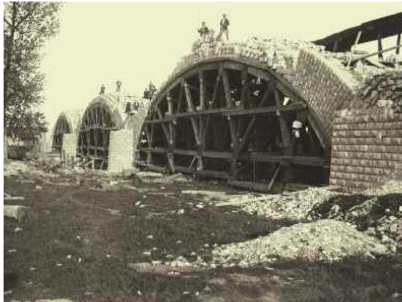
Photo n°10 : construction du viaduc de Verteuil (16) (crédit photo Gilles Pinganaud)
