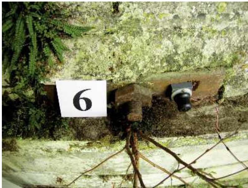
Photo n° 69 : contrôle d'un tirant ancien (crédit photo A. Bouineau)
