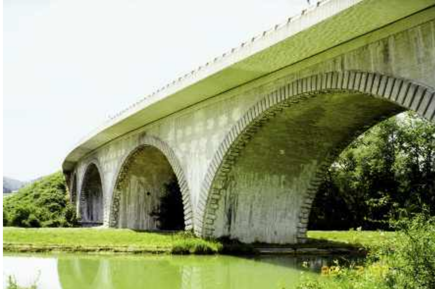
Photo n° 91 : pont de dit de 100 mètres après élargissement par une dalle générale appuyée sur le remplissage (crédit photo DDE 52)
