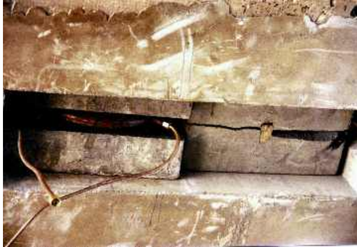
Photo n° 79 : vérin provisoire à gauche et bloc vérin définitif à droite (crédit photo Division des Ouvrages d'Art du CETE de l'Est)
