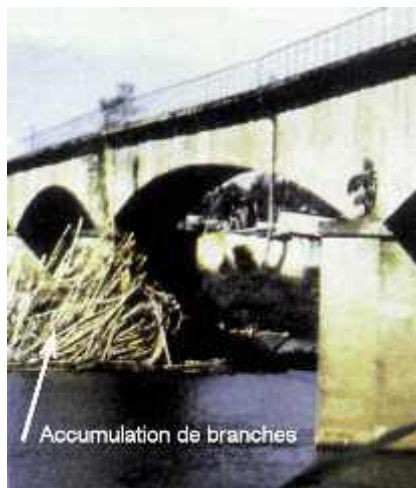
Photo n° 87 : accumulation de branches pouvant créer un phénomène d'embâcle (extrait IQDA - crédit photo SETRA)
