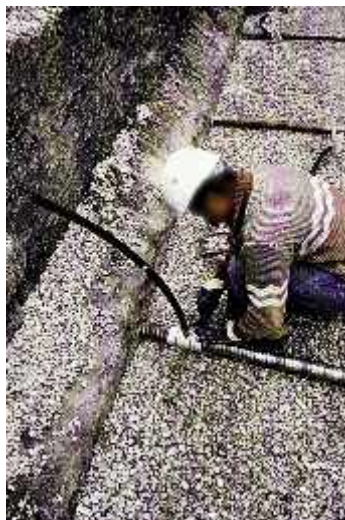
Photo n° 62 : mise en place de tirants d'enserrement actifs (crédit photo DDE 52)
