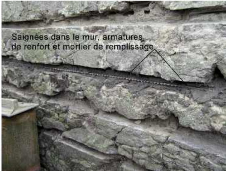
Photo n° 42 : détail du scellement des armatures de renfort dans les murs (crédit photo A. Bouineau)
