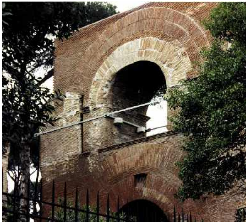
Photo n° 38: renforcement d'un monument à Rome (crédit photo D. Poineau)
