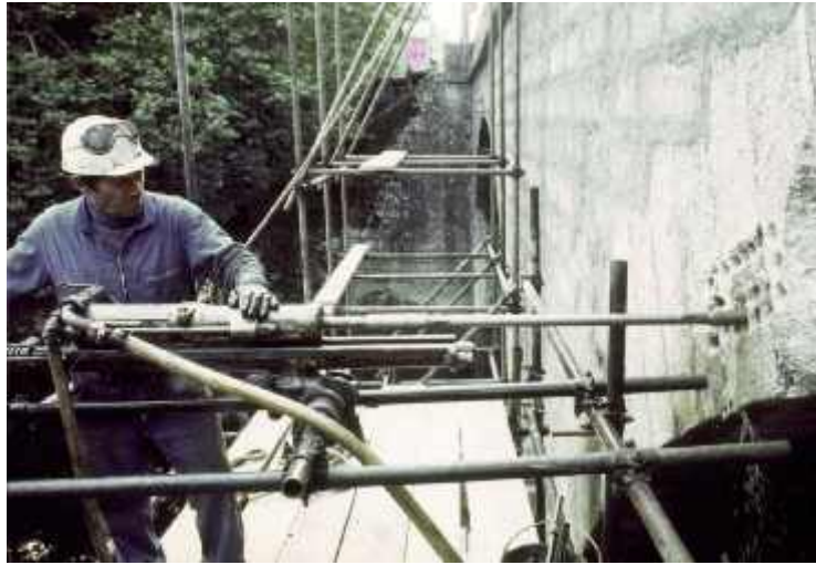
Photo n° 48 : forage au marteau hors trou pour la création d'une niche (crédit photo CETE de l'Ouest - Jacques Billon)
