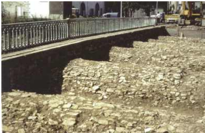
Photo n° 76 : état d'un extrados après décaissement et avant nettoyage (crédit photo SETRA)
