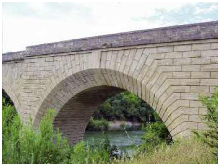
Photo n° 88 : élargissement du pont de Gignac au niveau des travées de rive (crédit photo Parexlanko)
