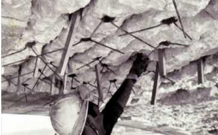
Photo n° 73 : scellement des épingles au pont de Favernay (crédit photo DDE 70)
