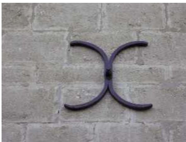
Photo n° 60 : plaque de répartition (crédit photo Cofex Littoral)
