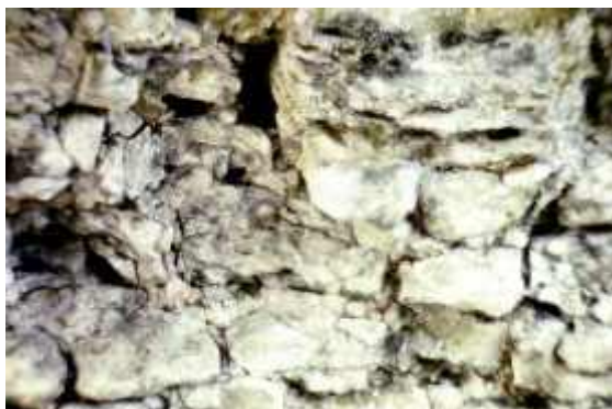
Photo n° 86 : état de l'intrados d'une voûte en pierres très sensibles au gel (crédit photo LRPC)
