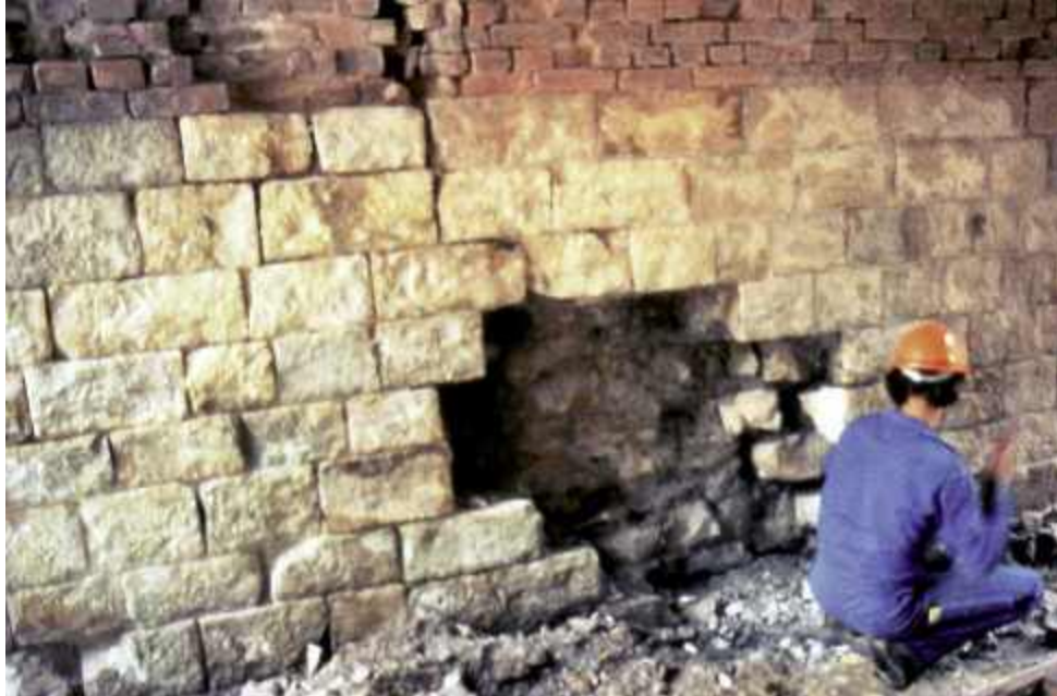
Photo n° 6 : purge et rescindement de la maçonnerie existante (crédit photo JL. Michotey)
