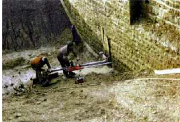
Photo n° 61 : forage des tympans pour le passage des tirants d'enserrement (crédit photo DDE 52)
