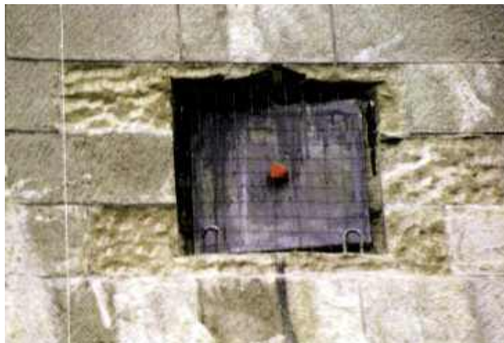
Photo n° 64 : pont dit de 100 mètres, plaque de répartition dans sa niche (crédit photo DDE 52)
