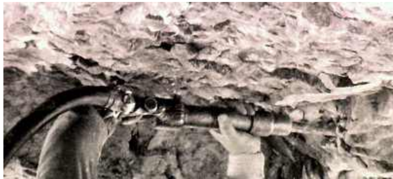
Photo n° 74 : rescindement de la voûte endommagée du pont de Favernay (crédit photo DDE 70)
