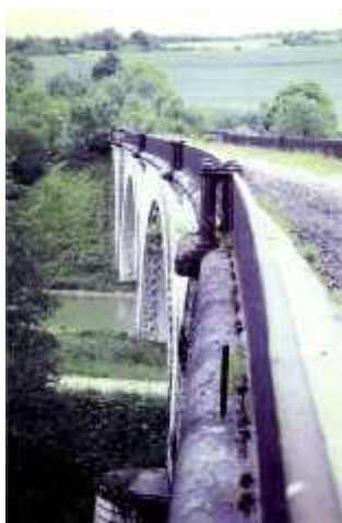
Photo n° 85 : pont dit de 100 mètres (ancien pont ferroviaire) avant son élargissement (crédit photo DDE 52)
