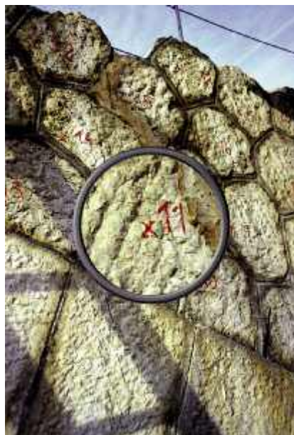
Photo n° 4 : repérage des moellons des tympons du pont de Villeneuve-Loubet avant leur démontage (crédit photo P. Vion)
