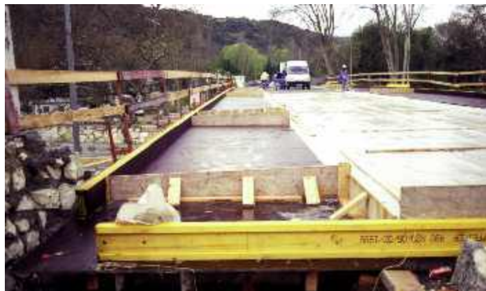
Photo n° 97 : coffrage pour la réalisation de la dalle générale d'élargissement du pont de Villeneuve-Loubet (crédit photo P. Vion)
