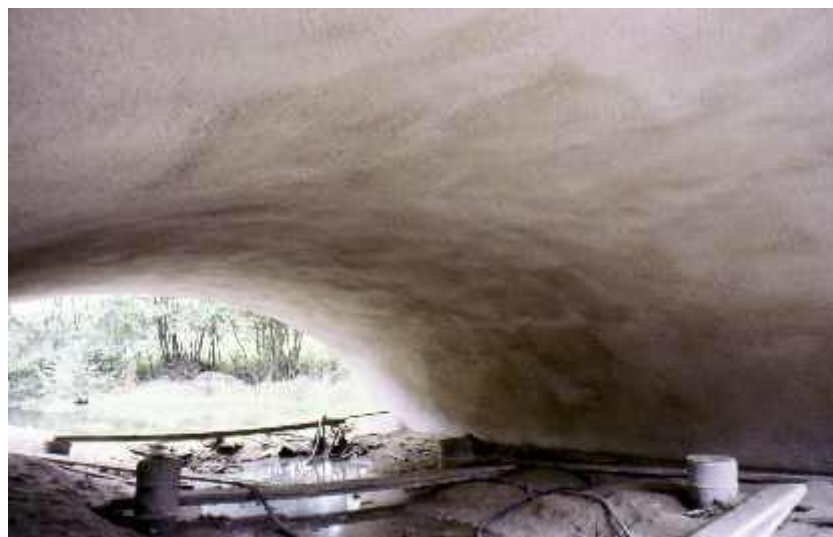
Photo n° 75 : contre-voûte en béton projeté du pont de Favernay terminée (crédit photo DDE 70)
