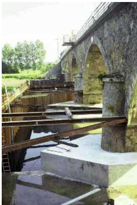
Photo n° 15 : batardeau de mise à sec des appuis (crédit phot. JP. Levillain)
