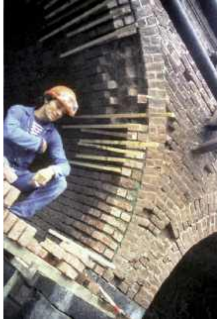
Photo n° 9 : réfection partielle d'une voûte en briques (crédit photo J.L. Michotey)
