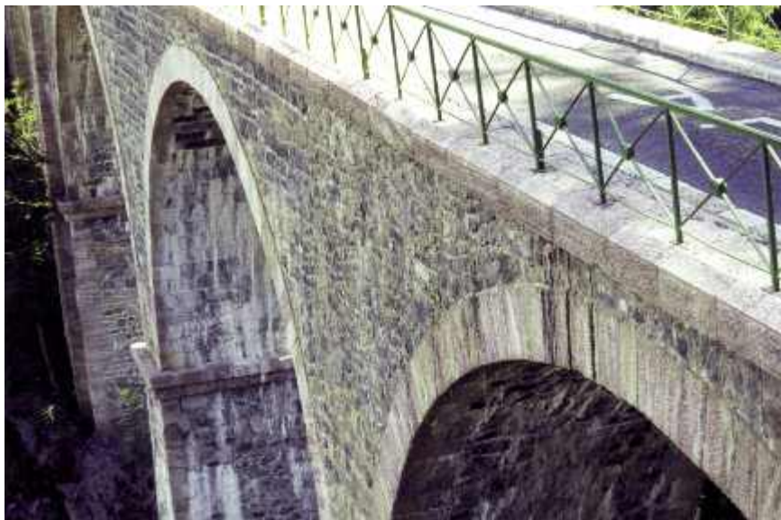
Photo n° 90 : pont très étroit à arches de faible portée qui pourrait être compatible avec une dalle générale appuyée sur les tympans, voire sur les tympans et le remblai (crédit photo D. Poineau)
