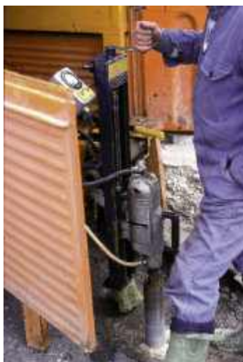
Photo n° 52 : carottage avec une couronne diamantée (crédit photo D. Poinéau)
