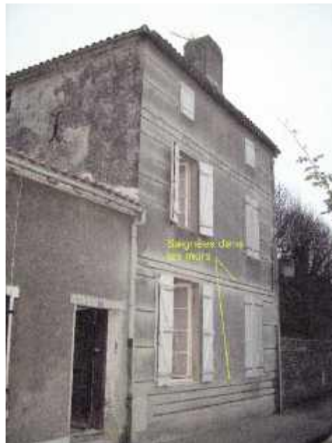
Photo n° 43 : renfort par armatures noyées dans les murs d'un bâtiment (crédit photo A. Bouineau)
