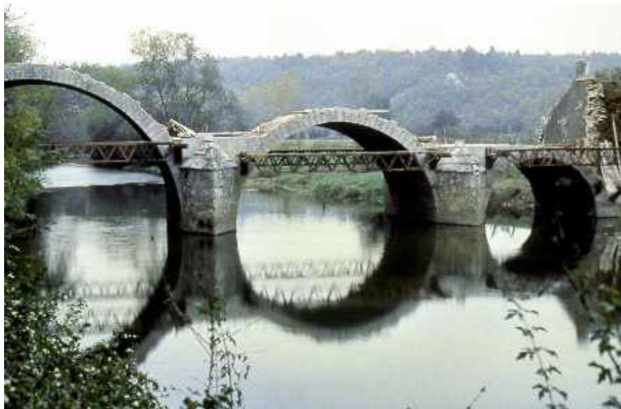
Photo n° 11 : travaux de réfection lourds (crédit photo JL. Michotey)
