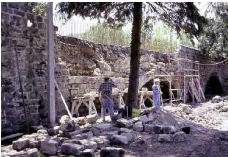
Photo n°8 : reconstruction d'un tympan en moellons assisés (crédit photo JL. Michotey)
