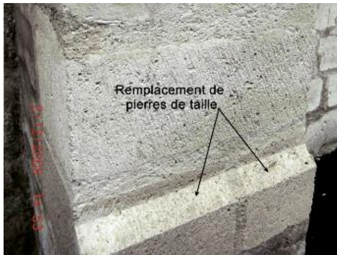
Photo n° 22 : exemple d'un remplacement de pierres de taille (crédit photo D. Poineau)
