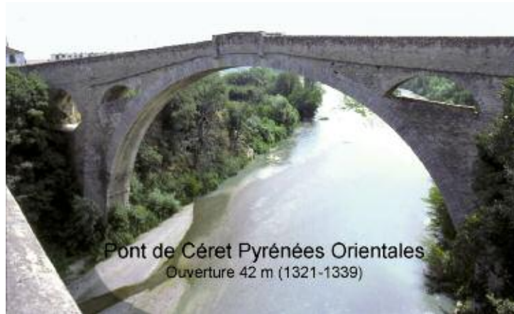
Photo n° 37 : pont en dos d'âne de Céret dans les Pyrénées-Orientales (crédit photo D. Poineau)
