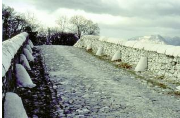
Photo n° 40 : pont de Lesdiguières [1608-1611] sur le Drac à Claix près de Grenoble (crédit photo J. L. Michotey)
