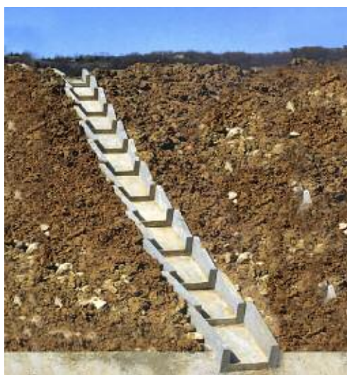
Photo n° 52 : descente d'eau préfabriquée sur un remblai (crédit photo LPB)
