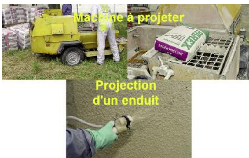
Photo n° 31 : chantier de projection (crédit photo Parexlanko)
