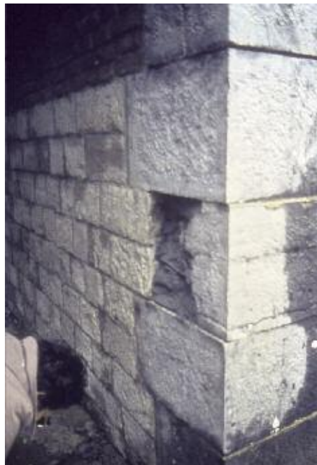
Photo n° 23 : début de la mise en place d'un mortier de restauration qui, normalement, aurait dû être armé (crédit photo J. L. Michotey)
