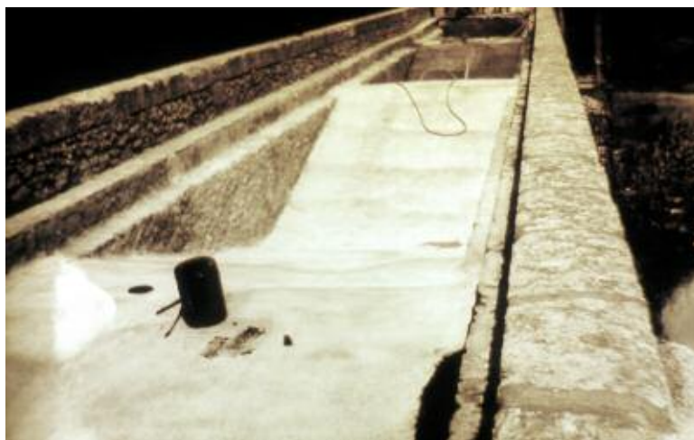
Photo n° 35 : voûtes après la réalisation d'un support en BA de la chape d'étanchéité (crédit photo LRPC)
