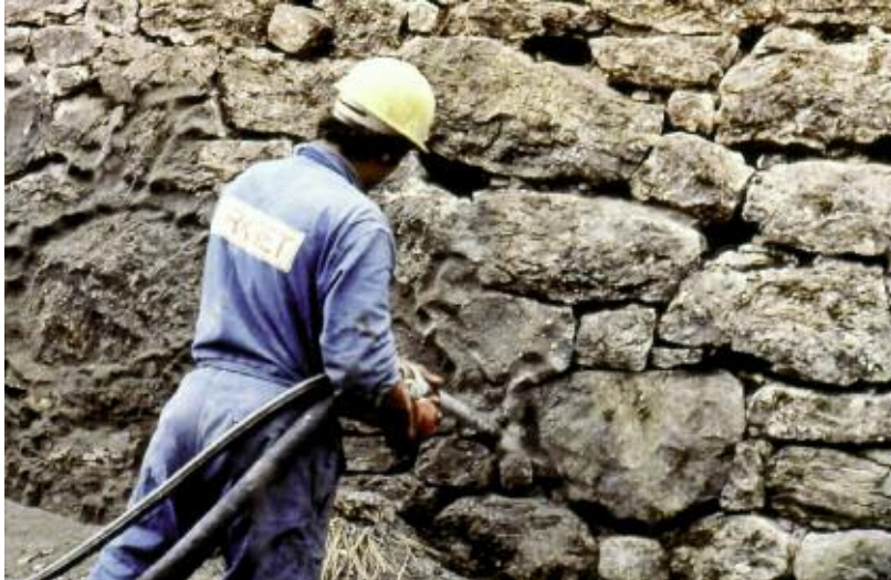
Photo n° 14 : remplissage des joints par voie sèche (crédit photo J. L. Michotey)
