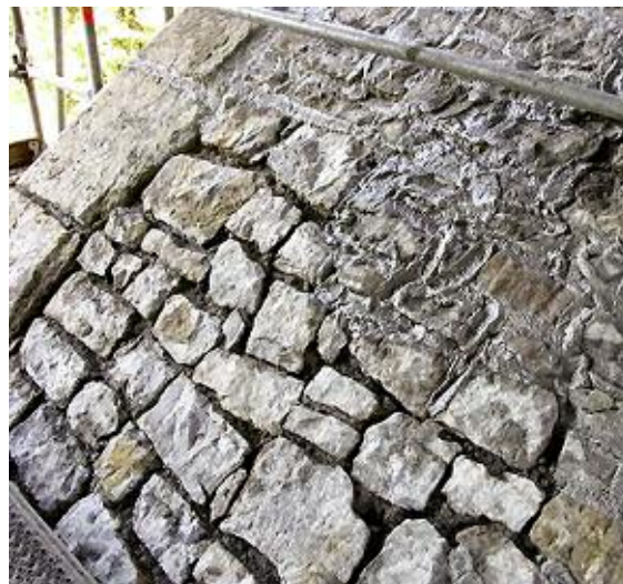
Photo n° 15 : rejointoiment de l'extrados du pont des Abarines (crédit photo CG du Gard)
