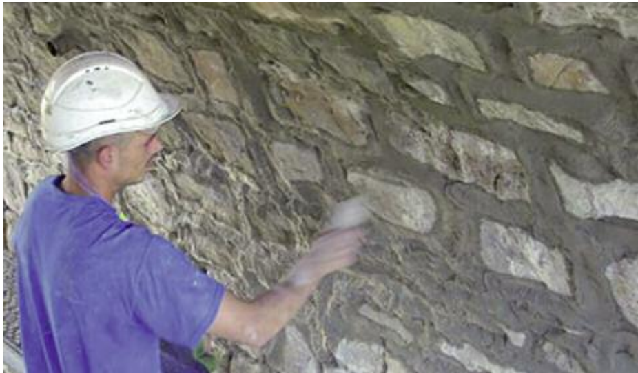
Photo n° 16 : travaux de finition au pont des Abarines (crédit photo CG du Gard)
