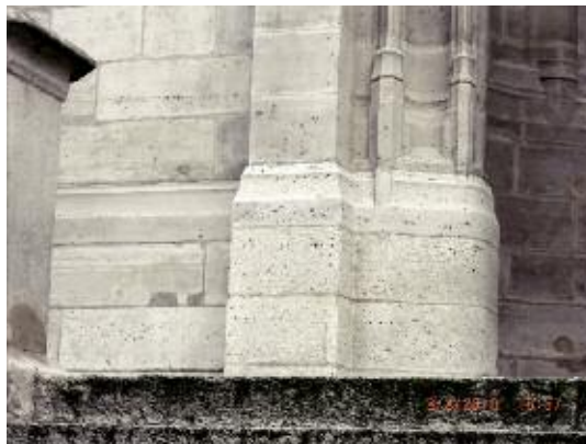
Photo n° 19 : réparation locale récente du soubassement de la Tour Saint-Jacques (crédit photo D. Poineau)
