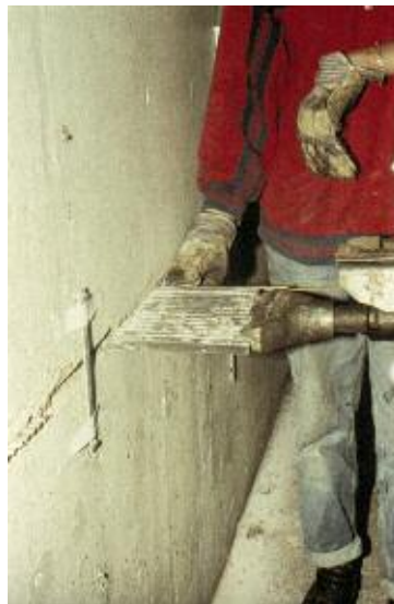
Photo n° 56 : mise en œuvre d'une plaque (crédit photo A. Bouineau)
