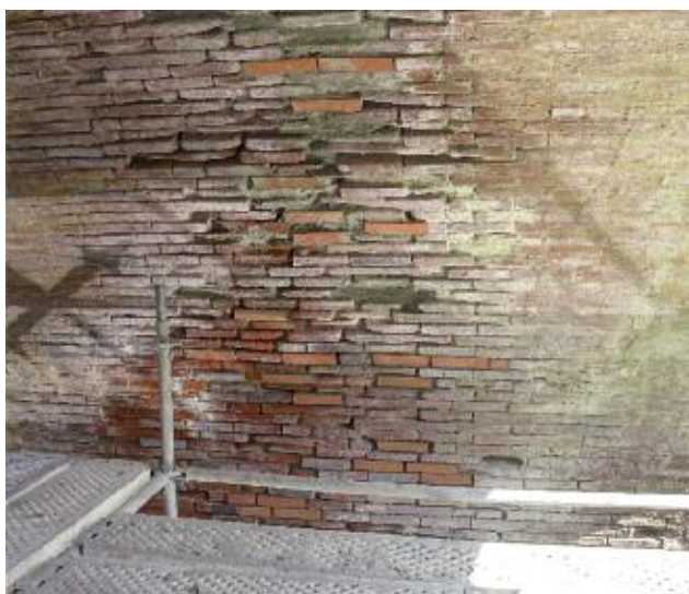
Photo n° 27 : travaux de remplacement de briques en cours (crédit photo Cofex Littoral)
