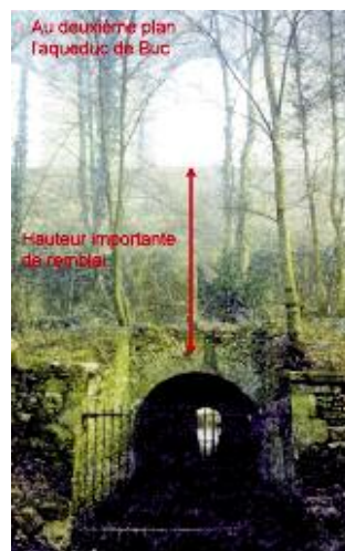
Photo n° 42 : galerie en maçonnerie sous un haut remblai et l'aqueduc de Buc (crédit photo CDOA des Yvelines)
