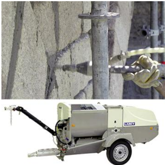
Photo n° 13 : remplissage des joint au moyen d'une buse par la voie mouillée basse pression (crédit photo CG du Gard)
