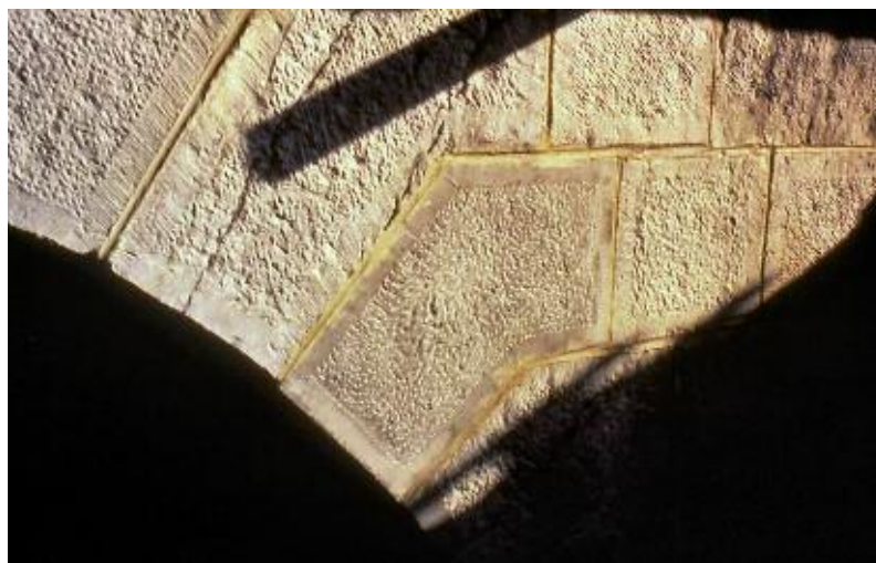
Photo n° 24 : travaux de ragréage à l'aide d'un mortier de restauration une fois terminés (crédit photo J. L. Michotey)
