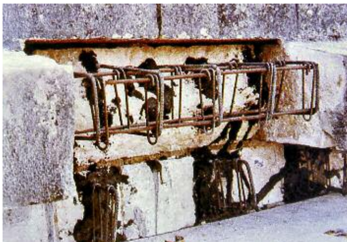
Photo n° 25 : exemple d'une mauvaise solution : pierre reconstituée en béton et ferrillée avec des armatures de béton armé ordinaires (crédit photo J. L. Michotey)
