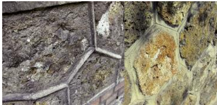
Photo n° 1 : joints saillants et joints à bords adoucis (crédit photo D. Poineau)
