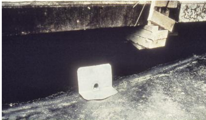
Photo n° 46 : sortie latérale d'une gargouille (crédit photo SETRA)
