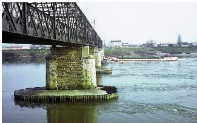
Photo n° 44 : pont de Thouaré sur la Loire : désordres dans une crèche (crédit photo JP. Levillain)
