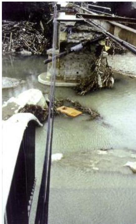
Photo n° 21 : effondrement d'un pont lors des crues du Sud-est en 1992 (crédit photo DDE 84)
