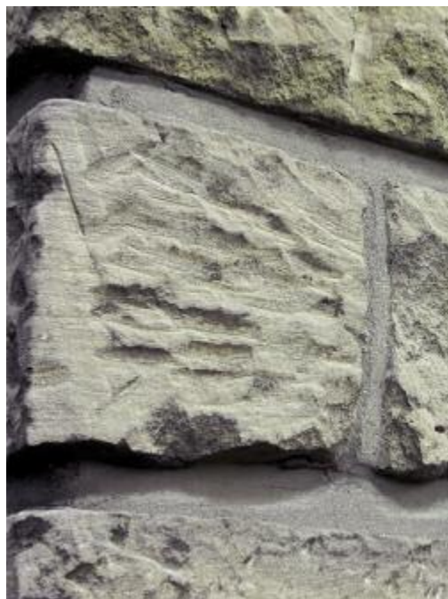
Photo n° 56 : finition brochée (crédit photo D. Poineau)
