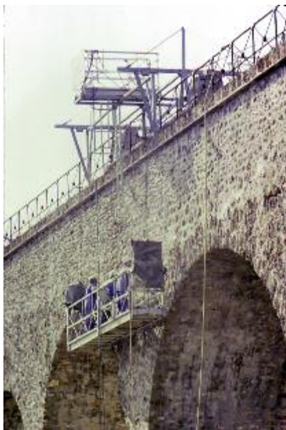
Photo n° 50 : aqueduc d'Arcueil-Cachan, échafaudage volant pour des travaux de ragréage (crédit photo D. Poinéau)
