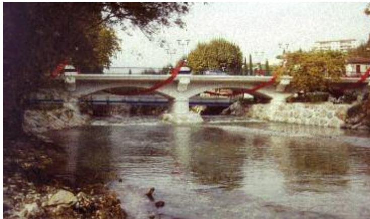
Photo n° 62 : pont de Villeneuve-Loubet le jour de l'inauguration après travaux d'élargissement (crédit photo CG 06)
