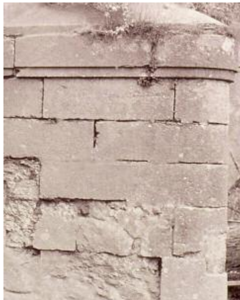
Photo n° 11 : désorganisation locale d'un parement en briques (crédit photo J. M. Michotey)
