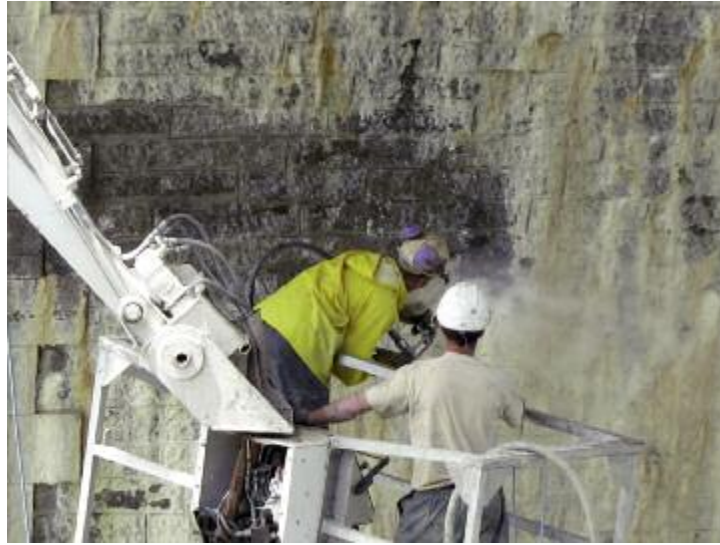
Photo n° 64 : décapage de coulure à THP (2500 bars) au pont des Abarines (crédit photo Cofex Littoral)
