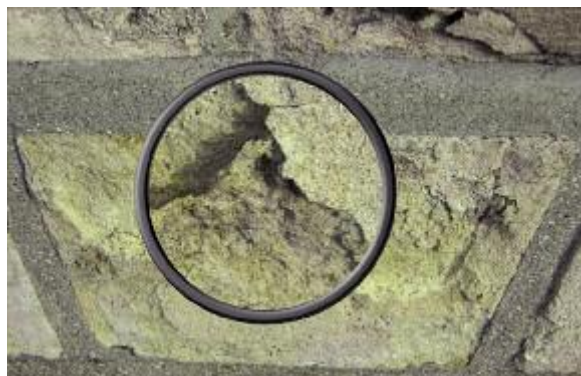
Photo n° 26 : maladie d'une pierre calcaire (crédit photo D. Poinéau)
