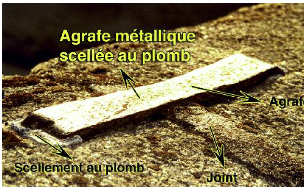
Photo n° 3 : couronnement d'un garde-corps à Dinan Côtes d'Armor (crédit photo D. Poineau)
