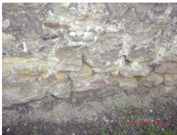
Photo n° 57 : mur en matériaux locaux (crédit photo D. Poinéau)
