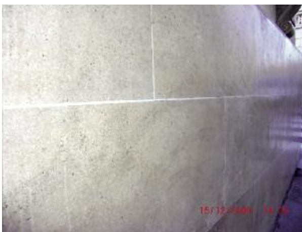
Photo n° 65 : revêtement anti-graffiti permanent sur un mur à Paris (crédit photo D. Poineau)
