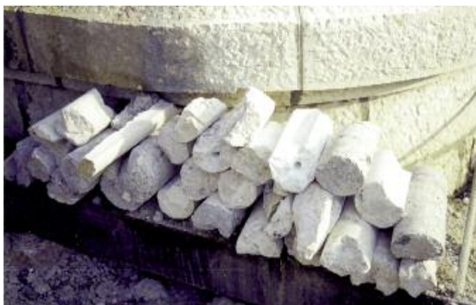
Photo n° 28 : carottes prélevées dans les pierres calcaires du pont de Villeneuve-Loubet (crédit photo P. Vion)
