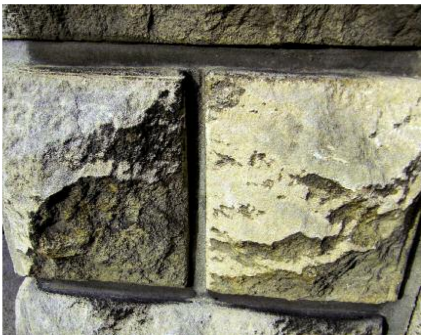
Photo n° 54 : finition bossagée (crédit photo D. Poineau)
