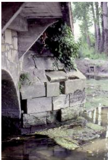
Photo n° 45: désorganisation de la maçonnerie par la végétation (crédit photo J. M. Michotey)
