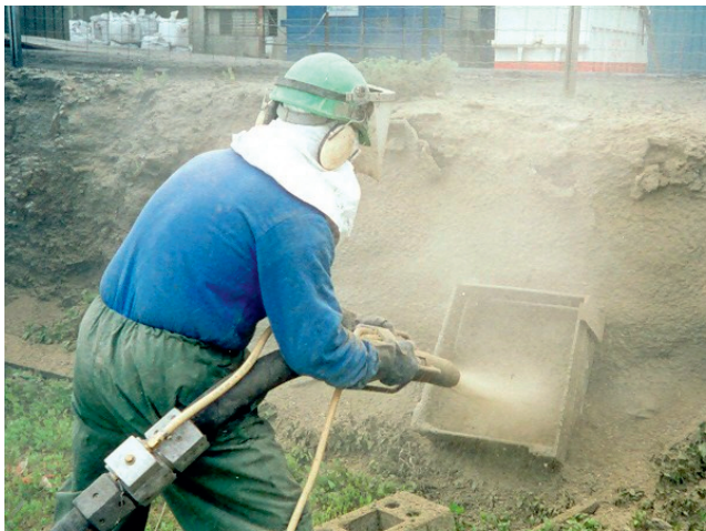
Lance voie sèche avec prémouillage
