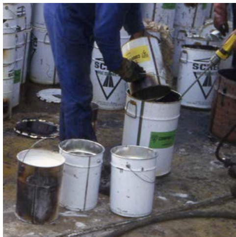
Photo n° 20 : opération de dilution d'une peinture (crédit photo Jean-Paul Benneton LRPC de Lyon)
