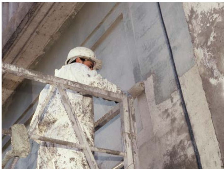
Photo n° 33 : application d'un revêtement au rouleau sur un pont (crédit photo Parexlanko)
