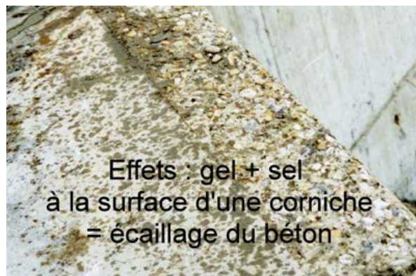
Photo n° 3 : désordres dus au gel de surface ou écaillage (crédit photo Poineau)
