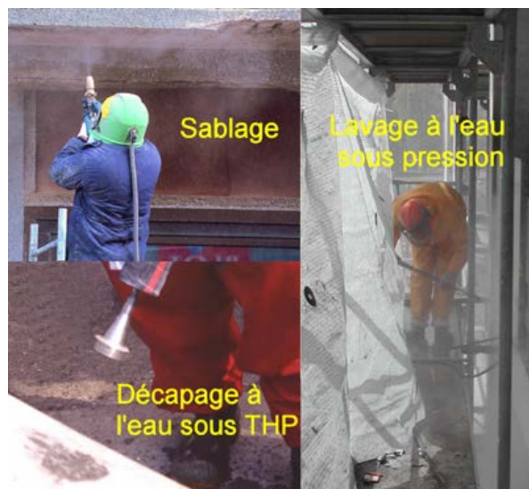
Photo n° 29 : nettoyage d'un support en béton à l'eau sous pression, à l'eau sous THP et par sablage (abrasifs autorisés) (crédit photo Parexlanko et Poineau)
