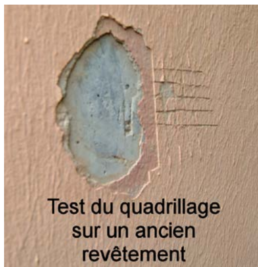
Photo n° 13 : test du quadrillage sur un revêtement existant (crédit photo Parexlanko)
