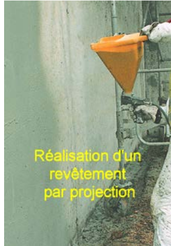
Photo n° 24 : chantier de projection d'un revêtement (crédit photo Parexlanko)
