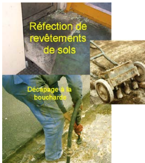
Photo n° 30 : décapage d'un ancien revêtement de sol (crédit photo Parexlanko et Poineau)
