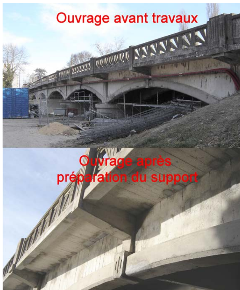
Photo n° 40 : état du support avant travaux et après préparation prêt pour les contrôles (crédit photo Parexlanko)
