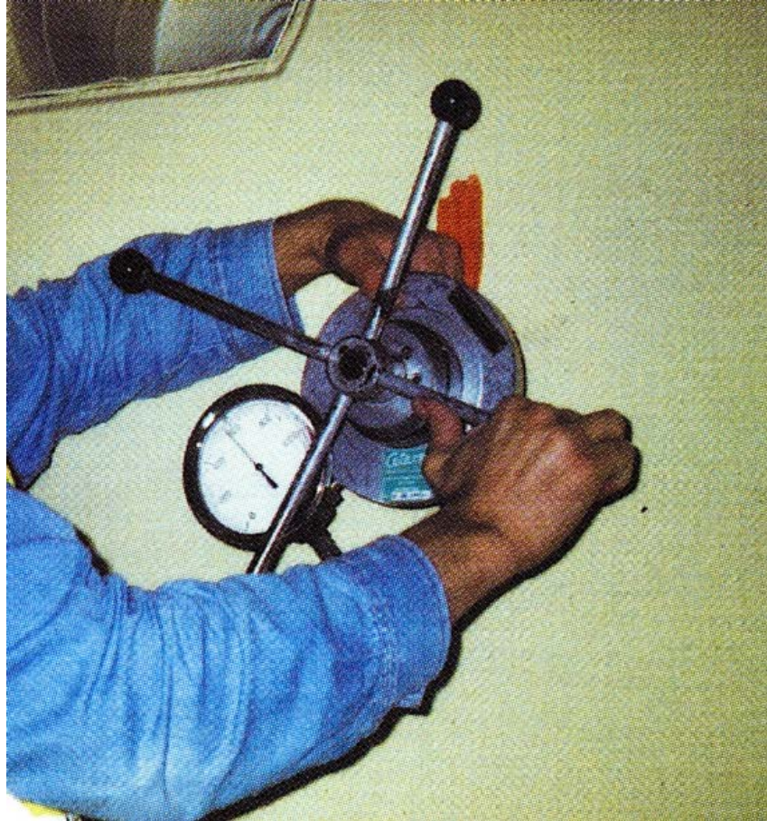
Photo n° 41 : contrôle de l'adhérence d'un revêtement par traction directe (crédit photo Jean Paul Benneton LRPC de Lyon)
