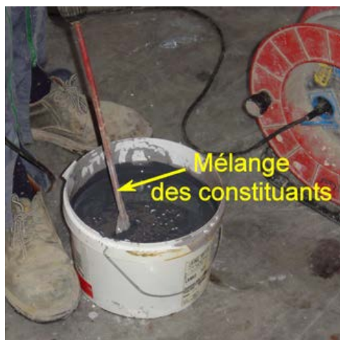
Photo n° 21 : mélange des constituants d'un revêtement à base de liants hydrauliques modifiés (crédit photo Parexlanko)
