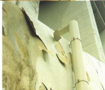
Photo n° 11 : incidences de l'orientation et des dispositifs de protection du support sur la tenue des revêtements (crédit photo Poineau)
