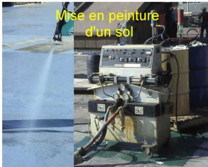
Photo n° 34 : atelier de mise en peinture d'un sol (crédit photo Jean-Paul Benneton LRPC de Lyon)
