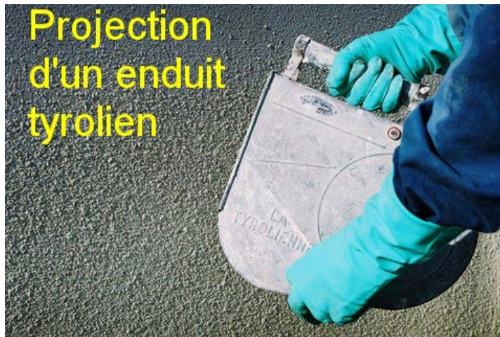
Photo n° 25 : machine à projeter manuelle dite « Tyrolienne™ » (crédit photo Parexlanco)
