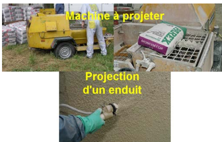
Photo n° 22 : machine à projeter avec sa cuve de malaxage et buse de projection en action (crédit photo Parexlanco)
