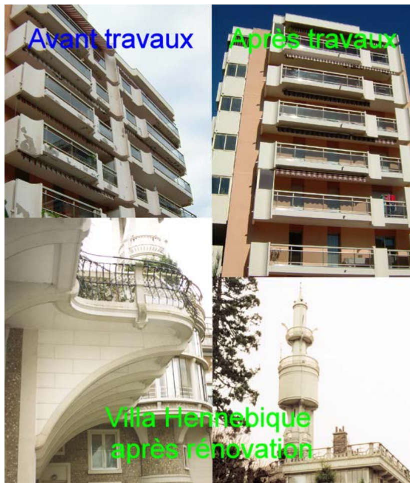
Photo n° 45 : bâtiments avant et après travaux (crédit photo Parexlanko et Poineau)
