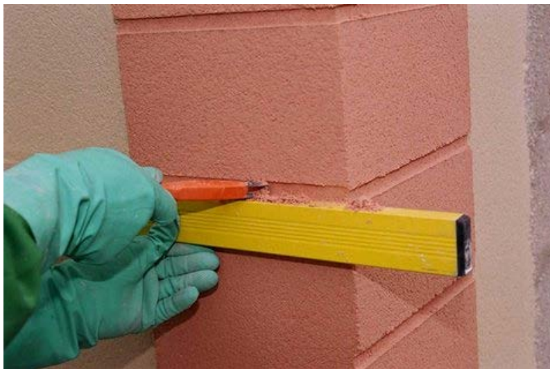
Photo n° 38 : réalisation d'un joint de fractionnement (crédit photo Parexlanco)
