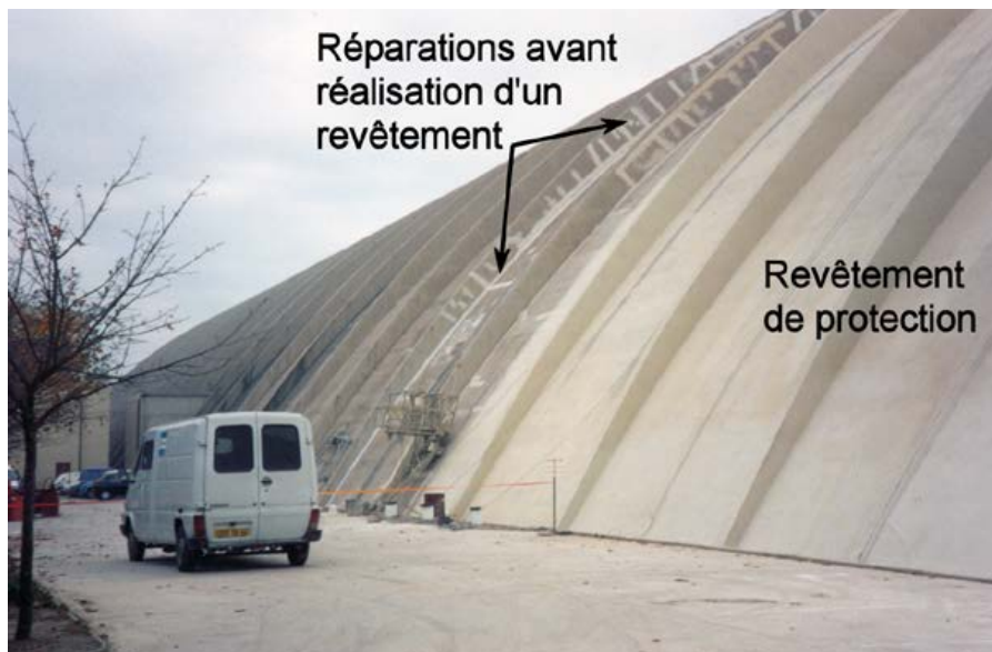
Photo n° 12 : chantier montrant la préparation du support et la protection réalisée (crédit photo Parexlanko)
