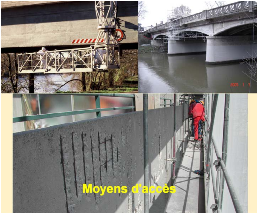
Photo n° 5 : moyens d'accès nécessaires pour l'exécution des travaux (crédit photo Parexlanko)
