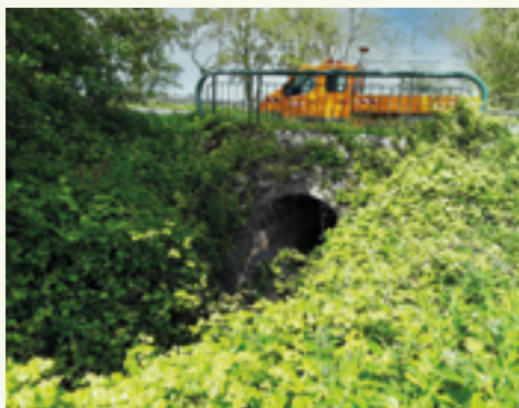
La dévégétalisation est une opération d'entretien courant qui permet de prévenir la dégradation des ouvrages
