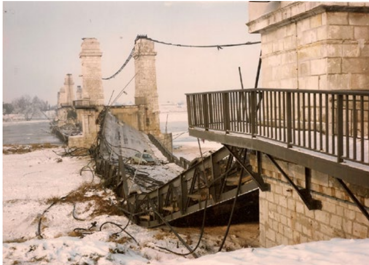
Figure 46 : effondrement du pont de Sully-sur-Loire en janvier 1985 (photo Jean-Paul PERSY).
