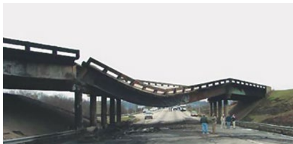
Figure 78 : Pont routier en Alabama USA - 5 janvier 2002 - incendie d'une citerne d'hydrocarbures (document Internet).
