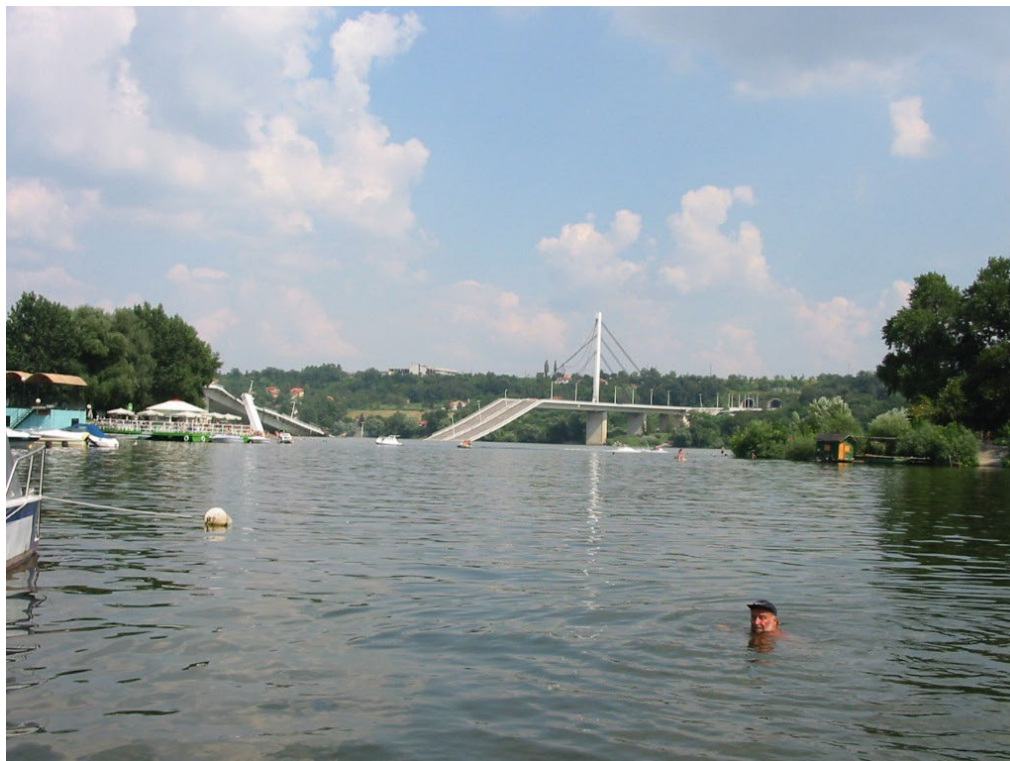
Figure 86 : Effondrement par fait de guerre d'un pont à haubans (photo Jean-Paul PERSY).
