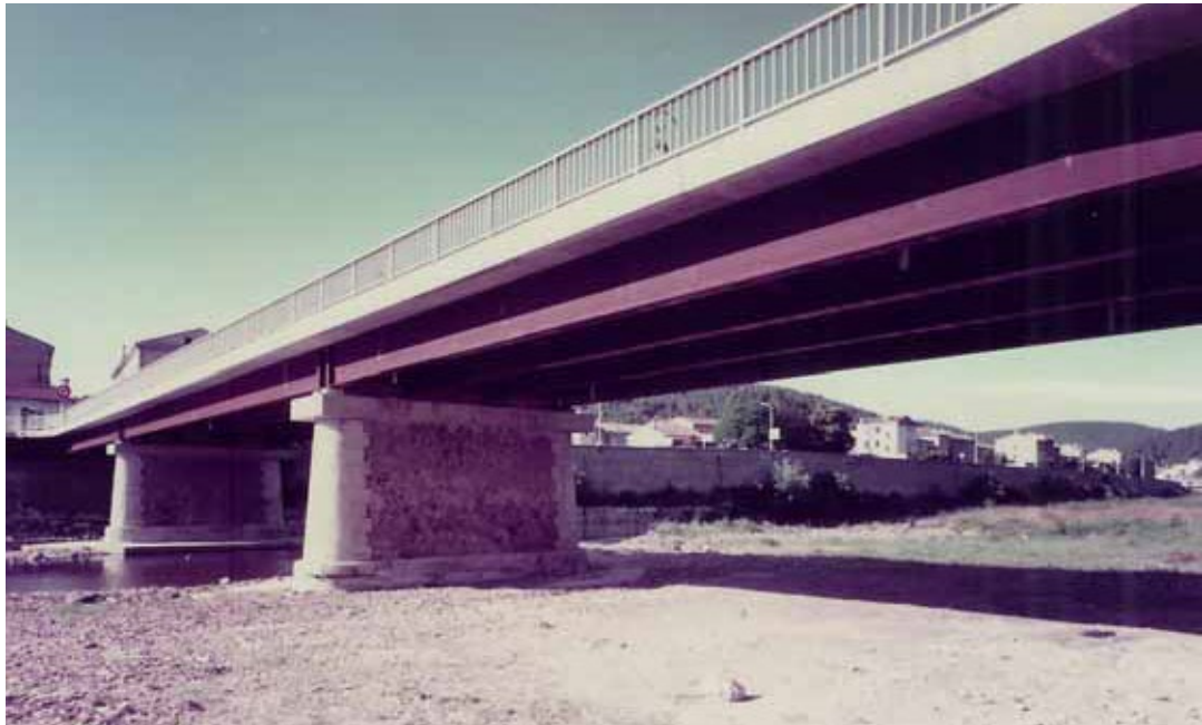
Fig. 17 : Ouvrage en acier à résistance améliorée à la corrosion atmosphérique : pont de Bessège (30) – (photo J. Richard-Ducros).
