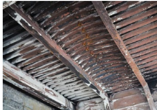
Figures 80 et 81 : Pont Mathilde Rouen - 29 octobre 2012 - accident d'un camion-citerne sur l'ouvrage et propagation de l'incendie sous l'ouvrage (documents Internet).
