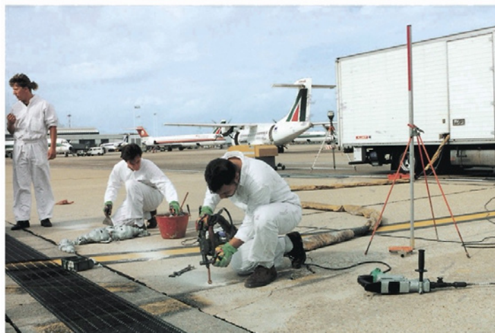
Photo n° 3 : élimination de battements de dalles (photo URETEK).
