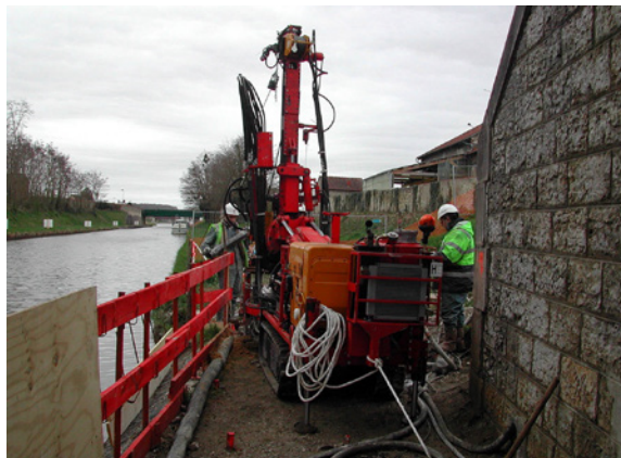
Photo n° 12 : sondeuse pour micropieux.
