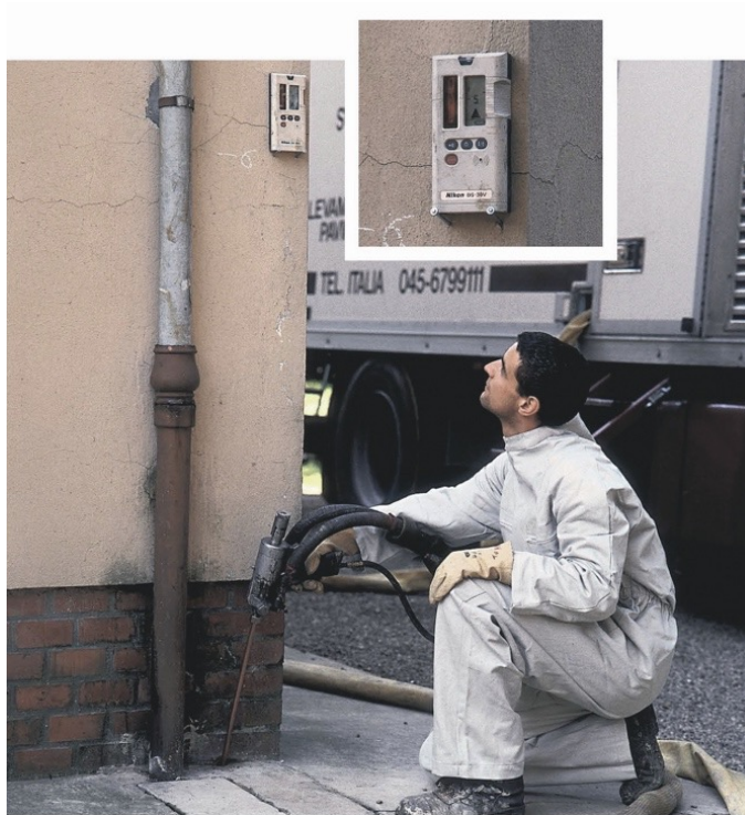
Photo n° 2 : opération de stabilisation d'un bâtiment avec contrôle de niveau (photo URETEKI).
