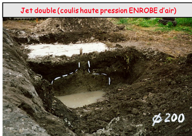
Photo n° 6 : colonnes de jet dégagées (photos Solétanche-Bachy).
