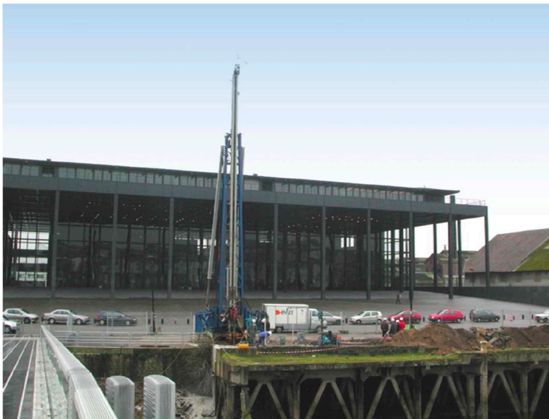
Photo n° 5: confortement de quai (photo Solétanche-Bachy).
