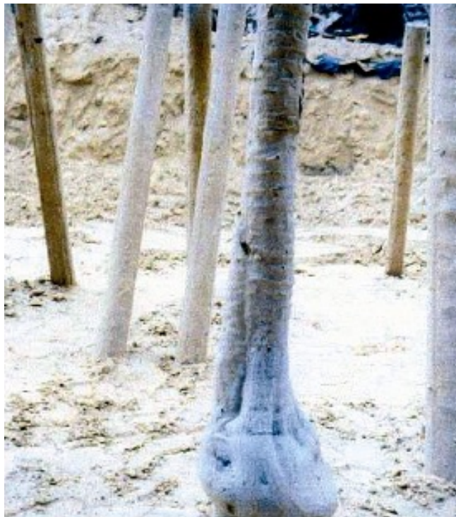
Photo n° 10 : micropieux excavés (photo projet national Forever).
