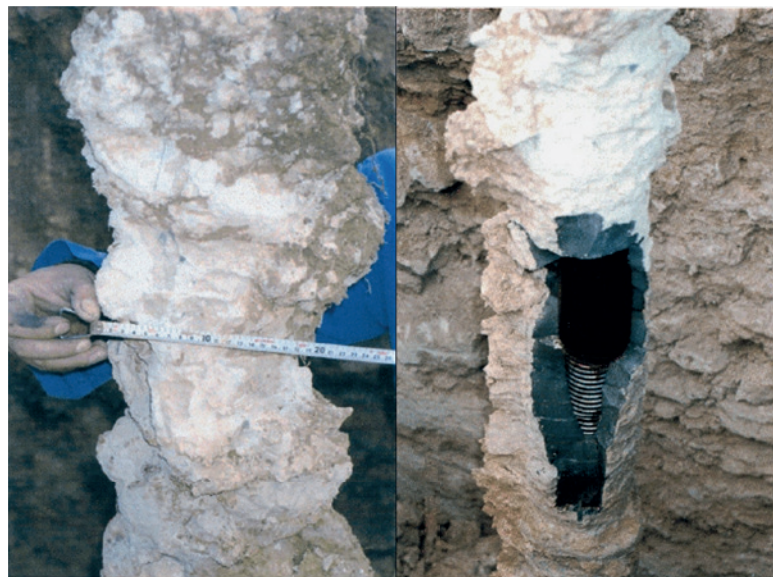
Photo n° 13 : bulbes de boulons d'ancrage déterrés (photos Ischebeck).
