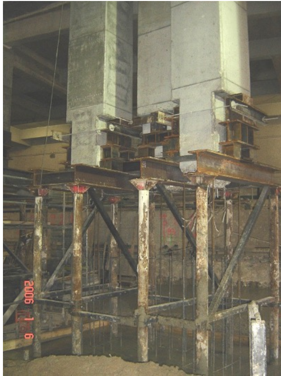
Photo n° 11 : reprise en sous-œuvre par micropieux.
