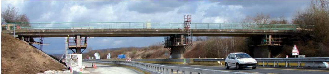
Figure 28 : Vue générale d'un chantier de vérinage sur un PS d'autoroute avec les dispositifs de sécurité pour la circulation sous l'ouvrage, les accès aux plateformes de travail fixées par consoles sur l'appui, etc. Crédit photo D. WEISSE - TSV
