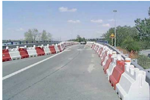
Figure 54 : Balisage de sécurité visant à bien positionner la voie laissée en circulation. A noter l'utilisation de SMV (Séparateur Modulaire de Voie) légers pour ne pas augmenter la charge à soulever. Crédit photo D. ESB RAT
