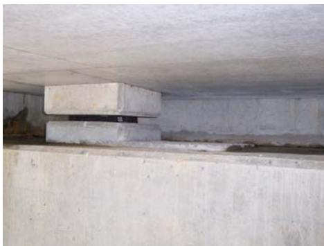
Figure 29 : Deux exemples de dispositions sur appui où les emplacements pour les vérins sont clairement matérialisés.
