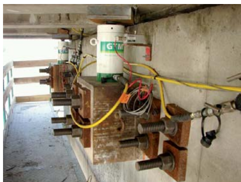
Figure 35 : Vérinage avec appui sur consoles bridées sur piles Crédit photo GTM Travaux Spéciaux
