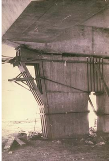
Figure 38 : Disposition d'appui hors structure existante à droite ou par brèlage sur l'appui à gauche
