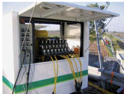
b) Groupe électrogène couplé avec les pompes et les électrovannes. Crédit photo GTM Travaux Spéciaux
