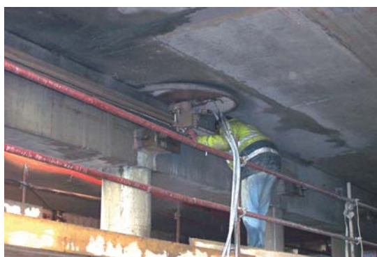
Figure 44 : Sciage d'une section rétrécie de béton. Ici avec une grande scie diamantée, des sciages au fil diamanté sont aussi réalisés.
