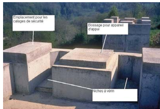
Figure 29 : Deux exemples de dispositions sur appui où les emplacements pour les vérins sont clairement matérialisés.
