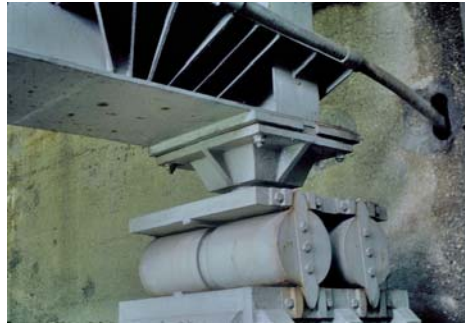
Figure 3 : Un bel exemple d'appareil d'appui métallique combinant un système à rouleaux pour les déplacements et une rotule pour les rotations. Crédit photo SETRA/CTOA
