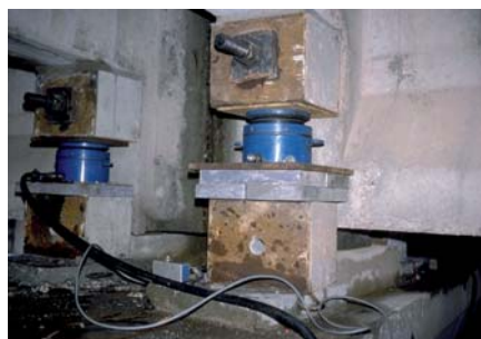
Figure 41 : Vérinage avec vérins de part et d'autre de la poutre. Ils s'appuient sur des blochets situés sous l'entretoise et fixés par précontrainte dans la poutre. A droite : Schéma de vérinage en hyperstatique.
