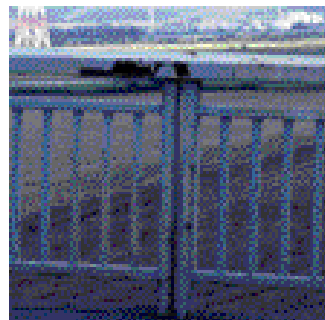
Figures 9 : corrosion «avancée» d'un garde-corps pouvant diminuer sa résistance. (Crédit photos SETRA/CTOA)
