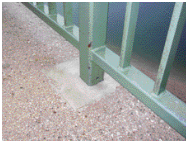
Figure 16 : trou de drainage dans la partie inférieure d'un profilé creux. Crédit photo M .Fragnet
