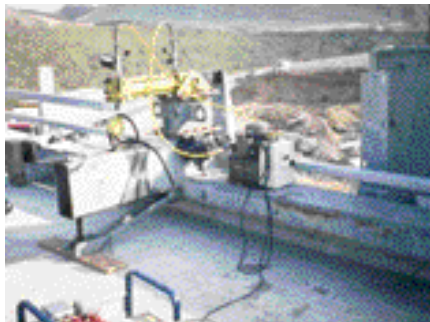
Figure 27 : Essai statique en cours sur un support de BN4 en vue de la vérification d'une réparation d'ancrage Crédit photo SETRA/CTOA
