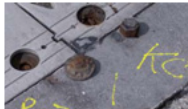
Rupture d'ancrage
