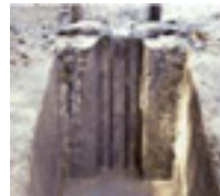
Joint CWS® Système d'étanchéité entre panneaux de paroi moulée.
