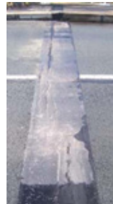
Figure 9 b : fissuration au droit de la plaque de pontage
