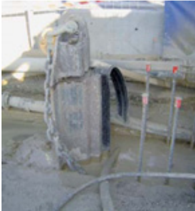
d) Joint par bande d'étanchéité en attente sur une paroi moulée. Crédit photo D. Criado
