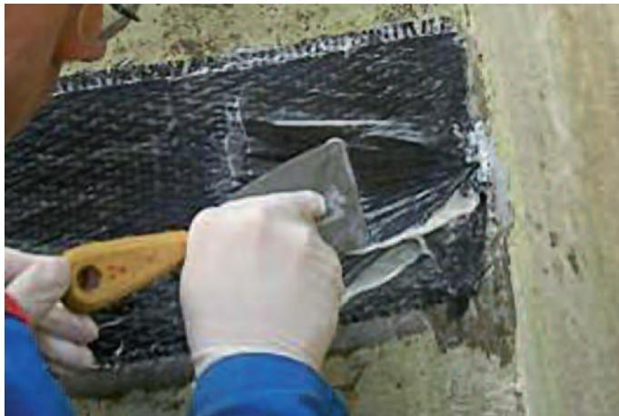
*Photo n° 51 : collage d'une mèche sur une bande de tissu (crédit photo Freyssinet)*
