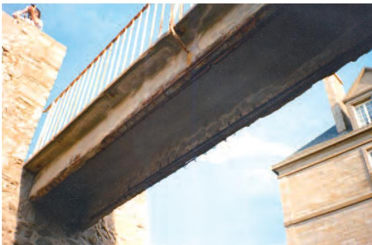
Photo n° 4 : état avancé de corrosion des armatures d'une passerelle piétons (crédit photo D. Poineau)
