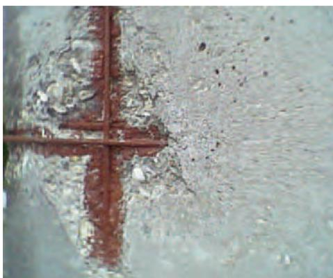
Photo n° 14 : mauvaise application d'un revêtement anticorrosion (crédit photo D. Poinneau)
