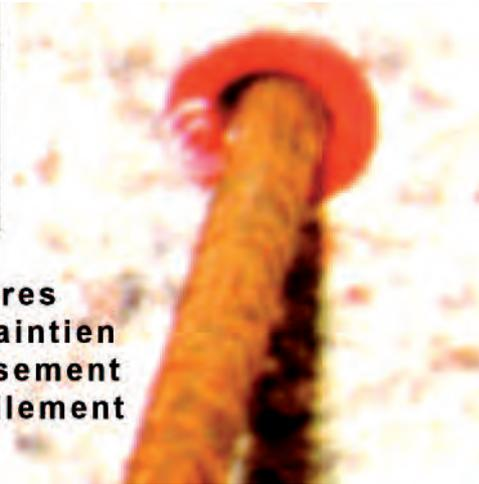
*Photo n° 12 : scellement d'armatures de béton armé (crédit photo D. Poineau)*
