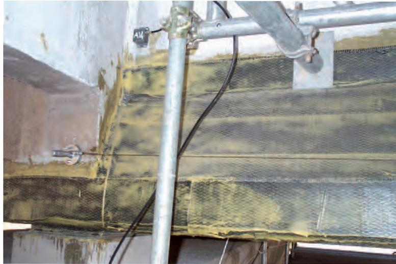
Photo n° 37 : renforcement en tissu composite des abouts des poutres du pont sur la Drôme (crédit photo RCA - M. Trouillet)
