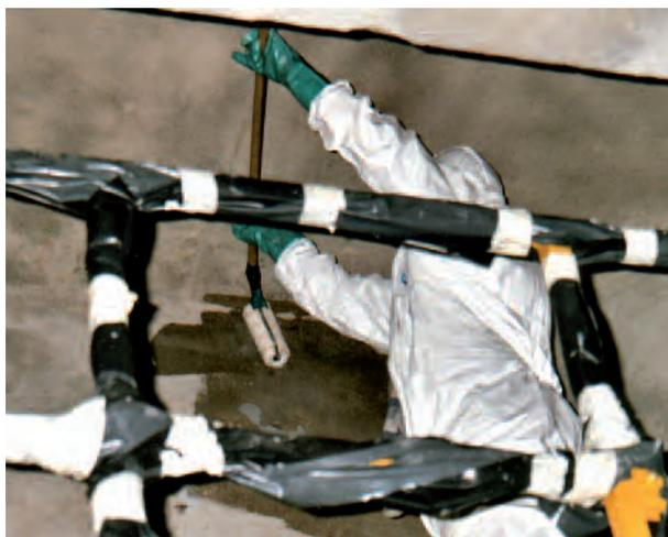
Photo n° 48 : encollage du support béton – Renforcement du pont sur le CD 126 à Arcueil (crédit photo D. Poinéau)
