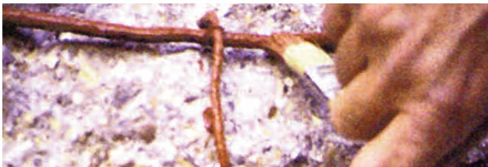
Photo n° 13 : bonne méthode d'application d'un revêtement anticorrosion sur des armatures de BA
