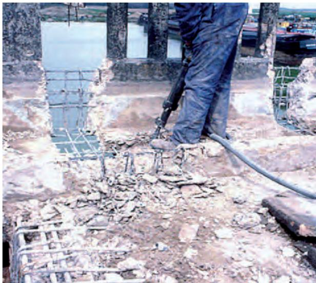
**Photo n° 9 : agressivité du marteau-piqueur sur les armatures de béton armé de faible ou moyen diamètre**
