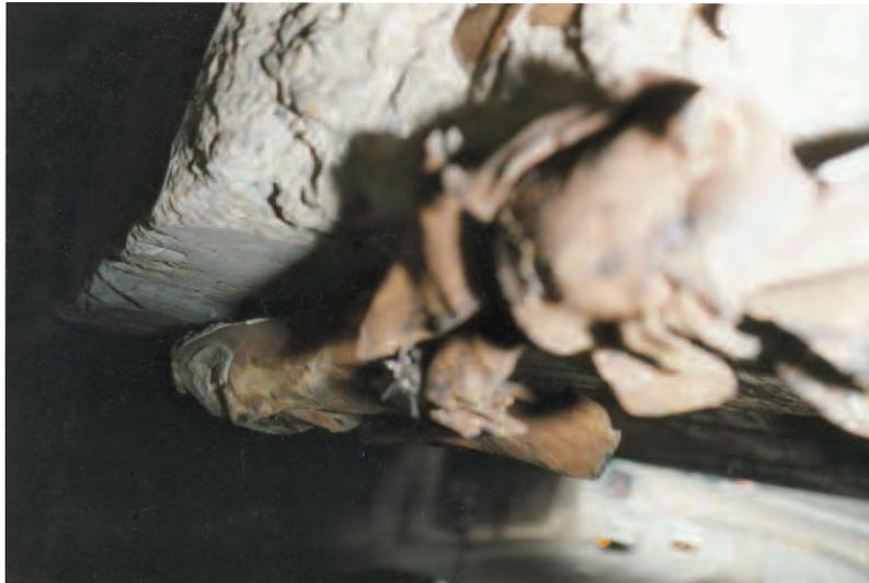
*Photo n° 27 : tôle collée sous le talon d'une poutre de rive et endommagée par les chocs de véhicules hors gabarit
