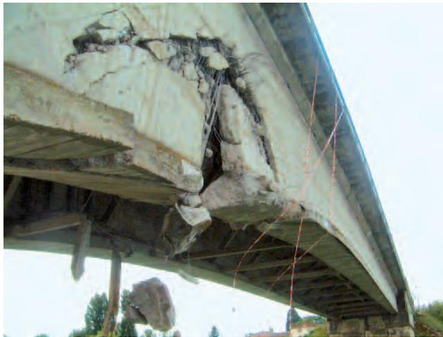
Photo n° 3 : conséquences d'un choc de bateau sur le tablier d'un pont en béton armé (crédit photo CETE de Lyon)
