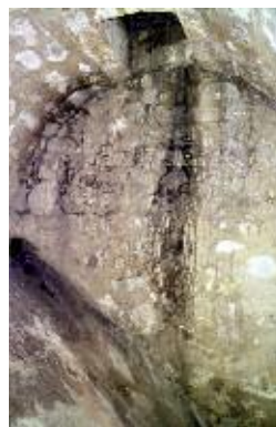
Photo n° 41 : intérieur d'un élégissement (crédit photo Michotey)
