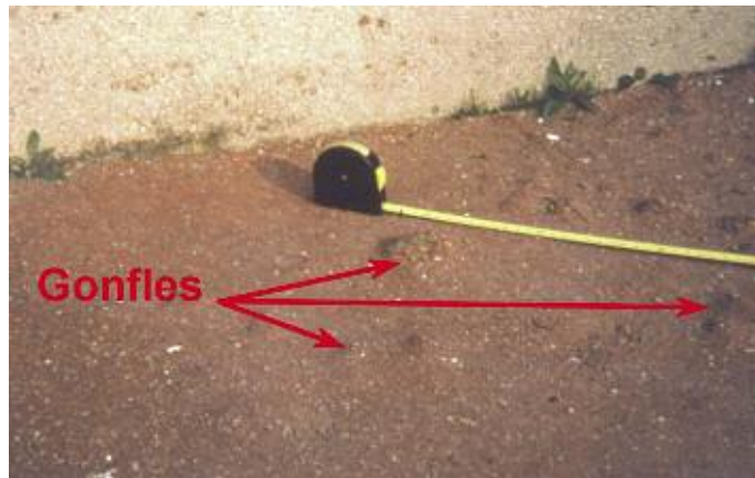
Photo n° 44 : gonfles sur un revêtement de trottoir en asphalte (crédit photo D. Poineau)
