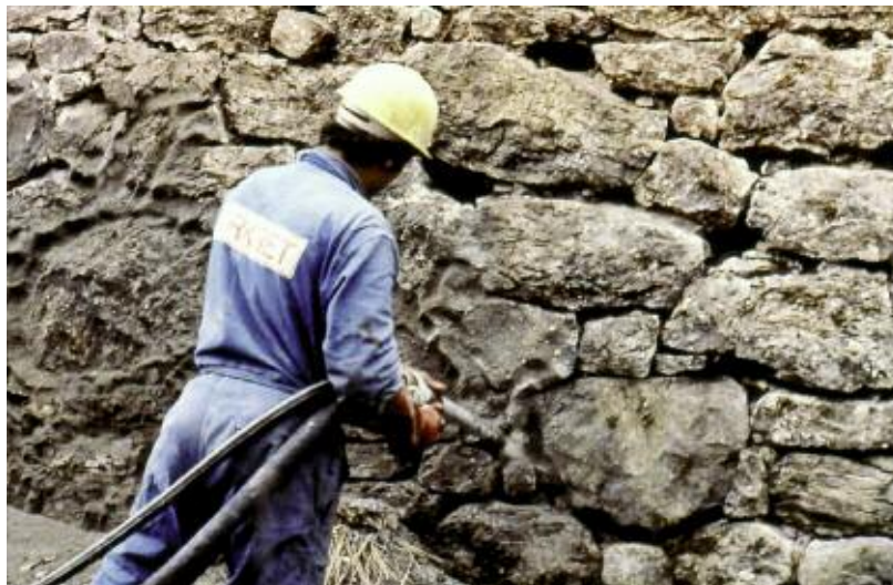
Photo n° 14 : remplissage des joints par voie sèche (crédit photo J. L. Michotey)
