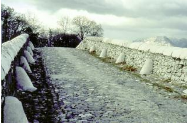
Photo n° 40 : pont de Lesdiguières [1608-1611] sur le Drac à Claix près de Grenoble (crédit photo J. L. Michotey)
