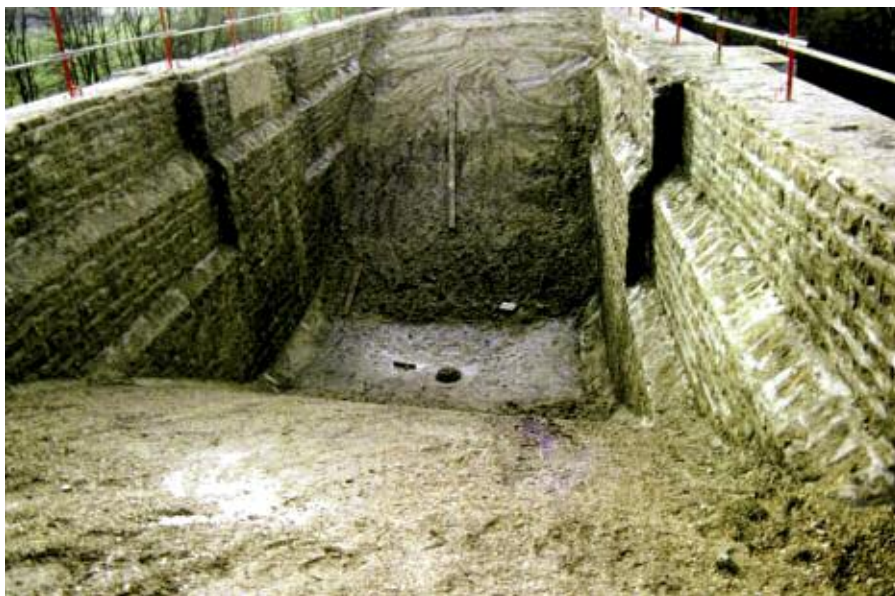
Photo n° 36 : zone d'accès difficile au pont dit de 100 mètres (crédit photo DDE 52)
