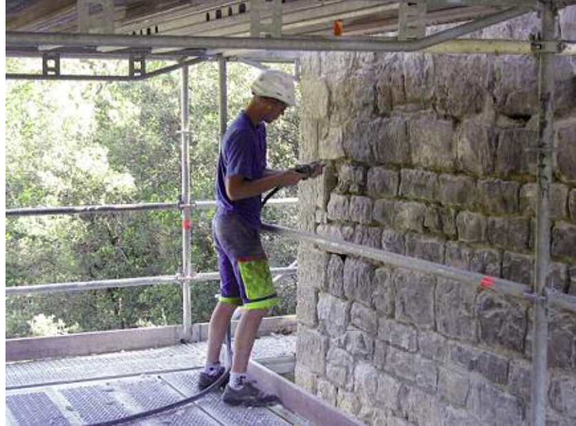
Photo n° 10 : dégarnissage des joints au marteau pneumatique au pont des Abarines (crédit photo CG du Gard)
