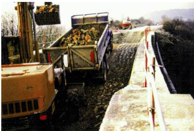
Photo n° 33 : décaissement en cours au pont dit de 100 mètres (crédit photo DDE 52)
