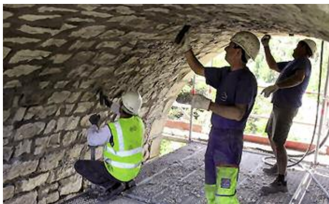
Photo n° 12 : finition à la brosse au pont des Abarines (crédit photo CG du Gard)
