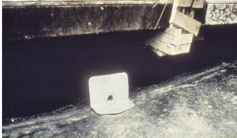
Photo n° 46 : sortie latérale d'une gargouille (crédit: photo SETRA)
