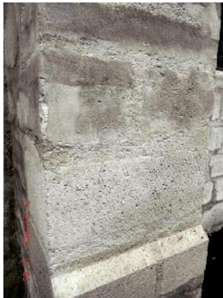
Photo n° 9 : utilisation d'un mortier adapté au rejointoiment (crédit photo D. Poineau)
