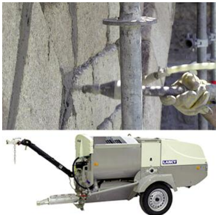
Photo n° 13 : remplissage des joint au moyen d'une buse par la voie mouillée basse pression (crédit photo CG du Gard)
