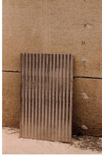
Photo n° 55 : plaque métallique gaufrée du procédé Huckendubler (crédit photo A. Bouineau)
