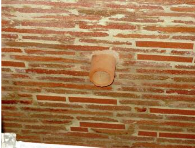
Photo n° 28 : travaux terminés (crédit photo Cofex Littoral)
