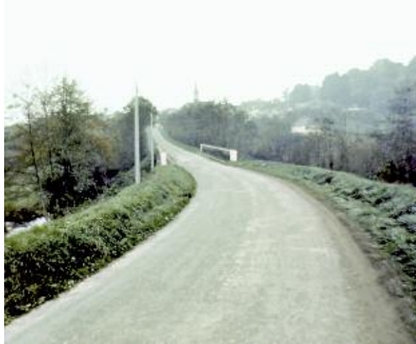
Photo n° 39 : pont en point bas (crédit photo CETE de l'Ouest - Jacques Billon)
