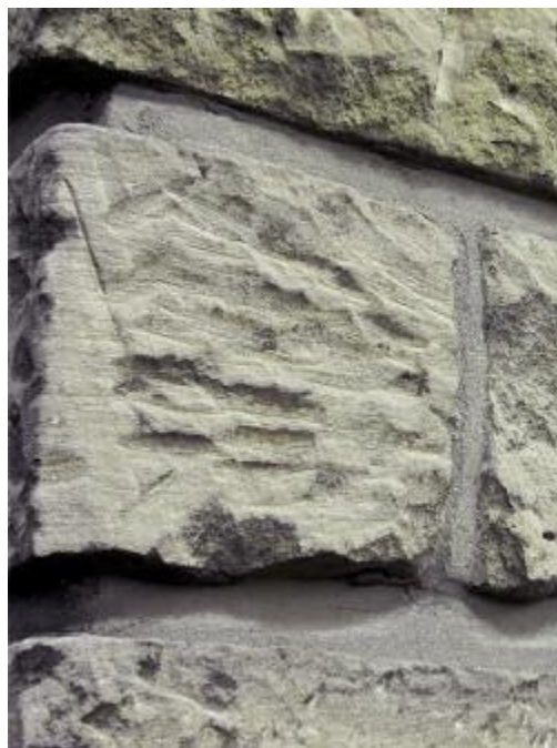
Photo n° 56 : finition brochée (crédit photo D. Poineau)
