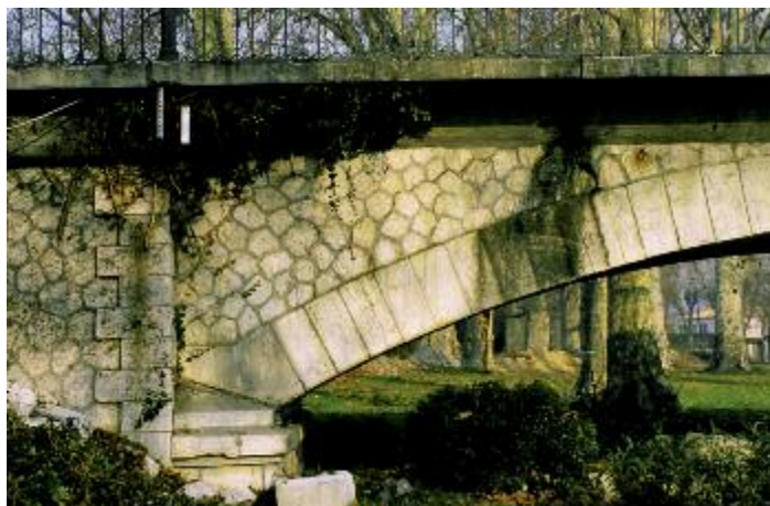
Photo n° 61 : pont de Villeneuve-Loubet avant travaux (crédit photo CG 06)
