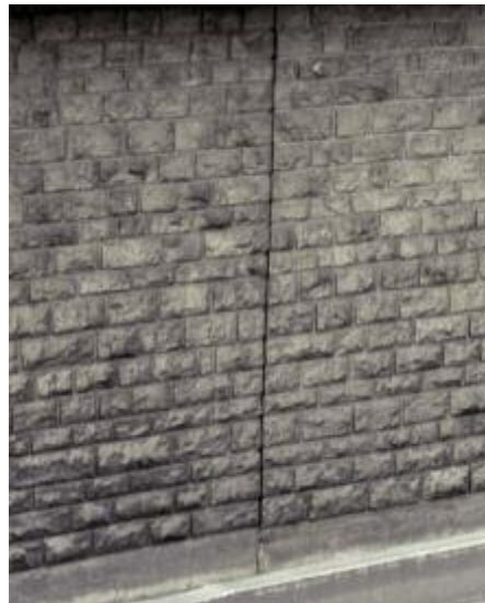
Photo n° 32 : joint de fractionnement (photo D. Poineau)
