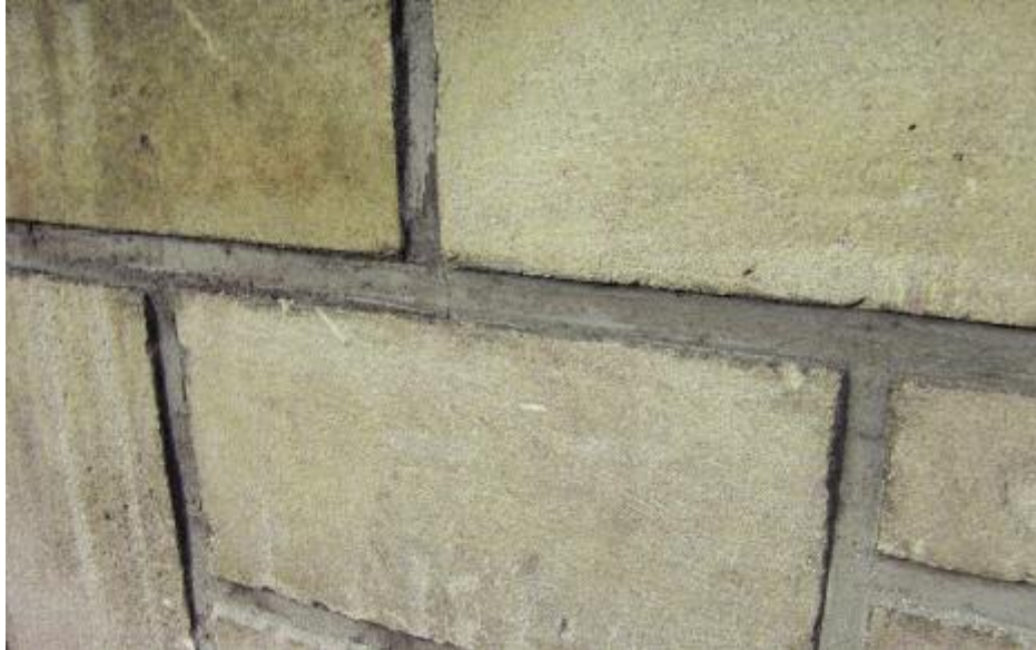
Photo n° 55 : finition sciée (crédit photo D. Poineau)
