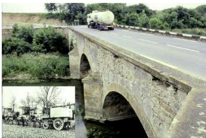
Photo n° 37 : transports de charges lourdes par fardier attelé à des chevaux de trait - Rechargement de chaussée excessif et circulation à ras des tympans sur un pont de la RN 3 (crédit photo chariotpierretaille_web.jpg, D. Poineau et J. M. Michotey)
