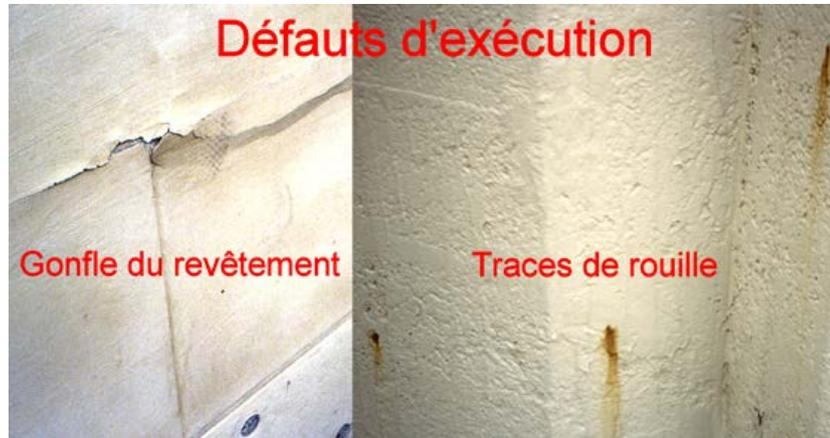
Photo n° 46 : défauts d'exécution pouvant apparaître avec le temps (crédit photo Poineau)
