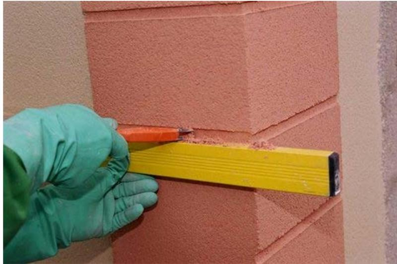
*Photo n° 38 : réalisation d'un joint de fractionnement
