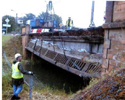
Photo n° 15 : conséquence de la circulation de l'eau au travers d'une fissure
