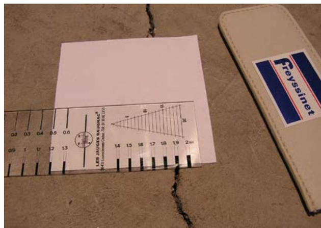
Photo n° 9 : fissure sur une paroi (crédit photo Freyssinet)
