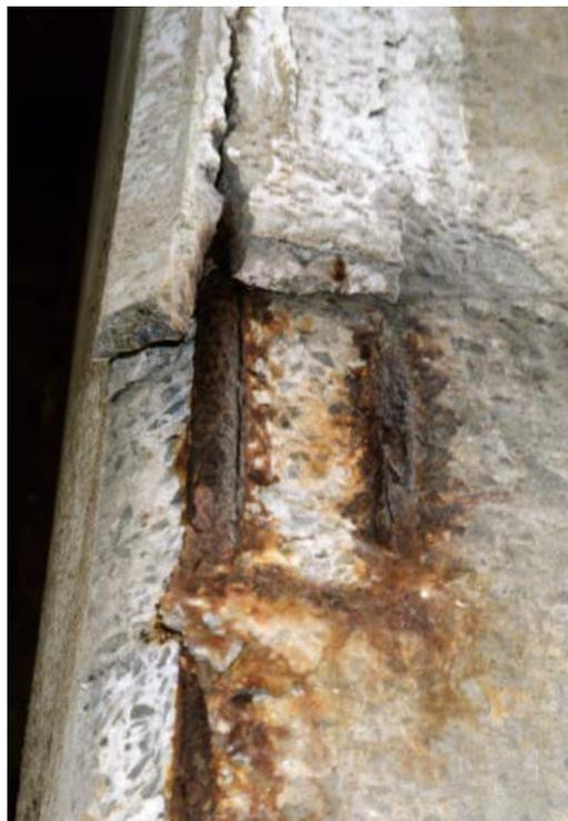
Photo n° 1 : désordres dus à la corrosion des armatures
