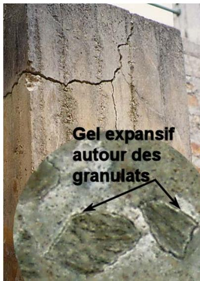
Photo n° 4 : désordres dus à une alcali-réaction
