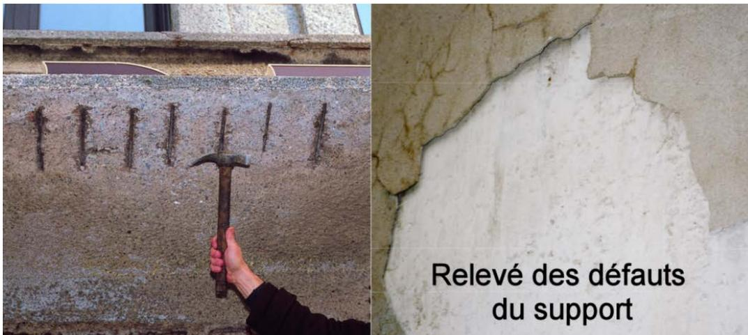
Photo n° 27 : relevé des défauts du support (crédit photo Parexlanko et Poineau)
