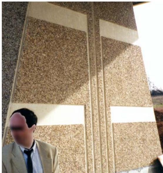
Photo n° 37 : exemple de joints de fractionnement dans le revêtement d'une pile d'un pont (crédit photo Poineau)
