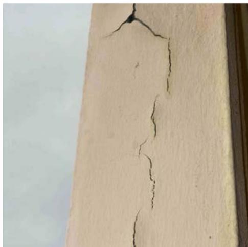
Photo n° 17 : éléments de faible section et revêtement de protection endommagé
