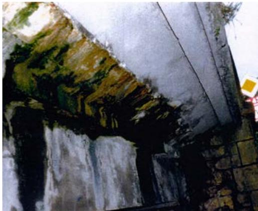
Photo n° 14 : exemple de fissure constamment humide
