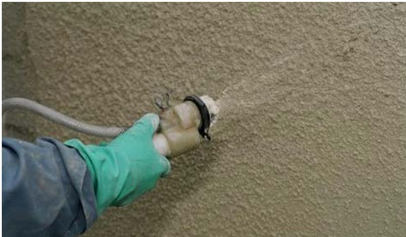
Photo n° 35 : réalisation d'un enduit monocouche avec une machine à projeter
