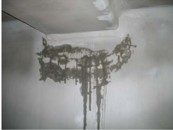
*Photo n° 47 : fuite sur la paroi d'un cuvelage (crédit photo Poineau)*
