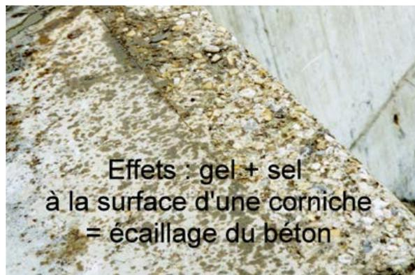
Photo n° 3 : désordres dus au gel de surface ou écaillage
