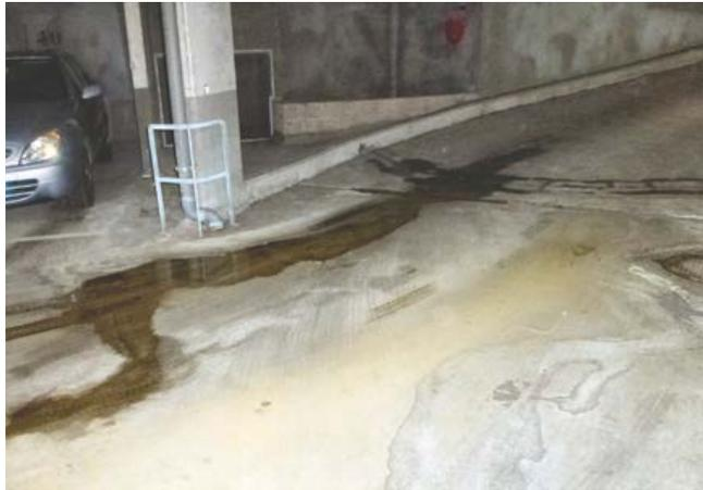
Photo n° 32 : fuites à la jonction d'une rampe et d'un plancher d'un cuvelage (crédit photo Poineau)
