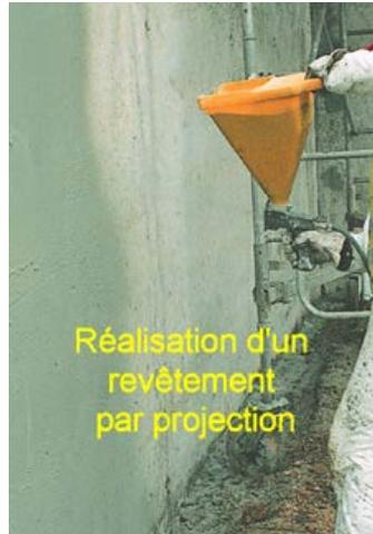
Photo n° 24 : chantier de projection d'un revêtement
