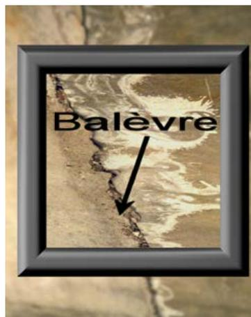
Photo n° 6 : exemple de défaut géométrique (crédit photo Poineau)
