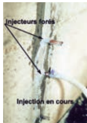
Photo n° 34 : opération d'injection avec des injecteurs forés (crédit photo Parexlanka)
