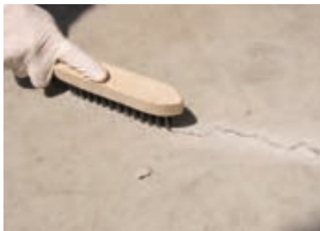
Photo n° 28 : nettoyage d'une fissure avec une brosse métallique (crédit photo Freyssinet)
