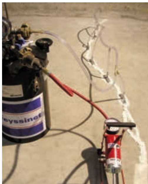
Photo n° 39 : exemple d'injection par groupe d'évenés (crédit photo Freyssinet)
