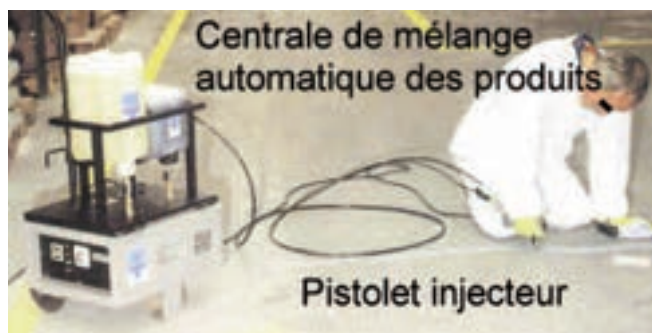
Photo n° 14 : utilisation d'un pistolet injecteur (d'après un document du procédé Concrèscive MBT) (crédit photo MBT)
