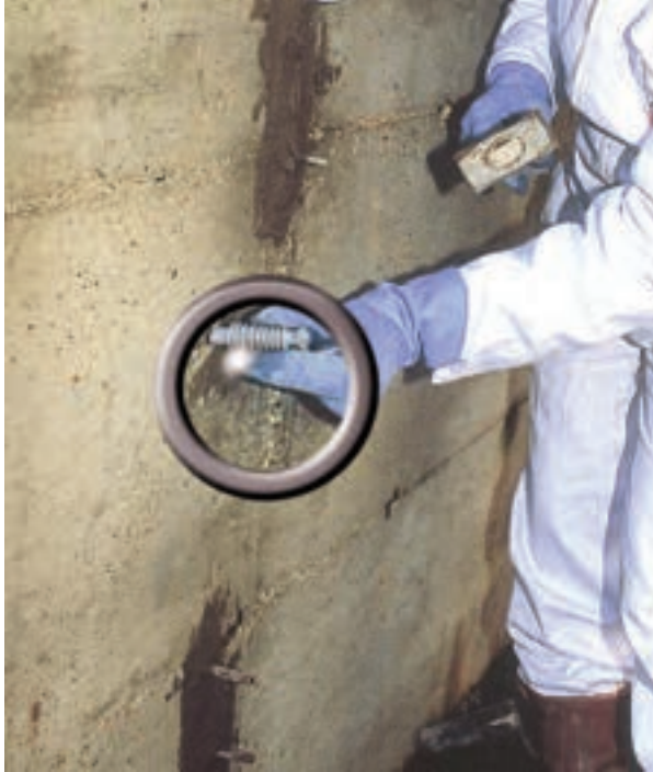
Photo n° 21 : mise en place d'injecteurs dans des trous forés (crédit photo Parexlanko)
