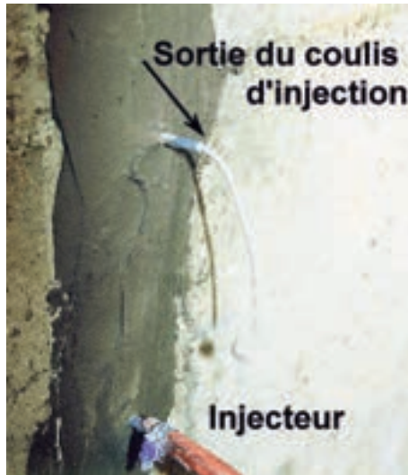
Photo n° 45 : contrôle de la sortie du coulis d'injection aux événements (crédit photo Parexlanko)
