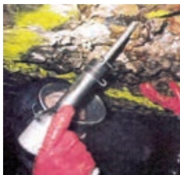
Photo n° 41 : la présence d'eau rend les travaux difficiles (crédit photo Parexlanko)
