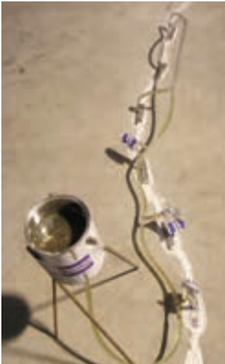
Photo n° 44 : injection en cours, contrôle du remplissage des événements (crédit photo Freyssinet)
