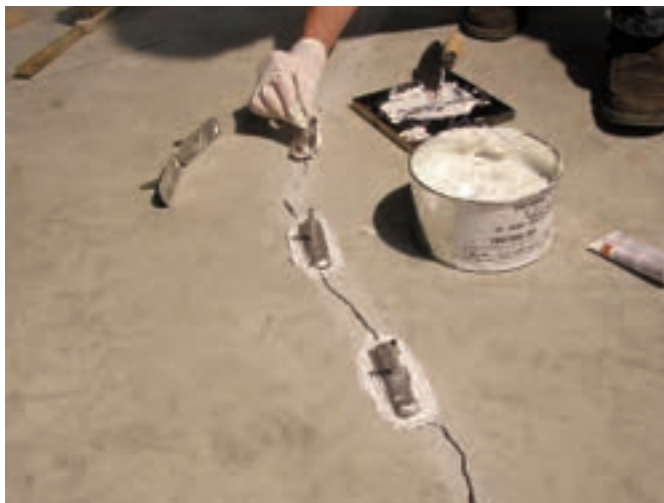
Photo n° 9 : fissure en cours de cachetage (crédit photo Freyssinet)
