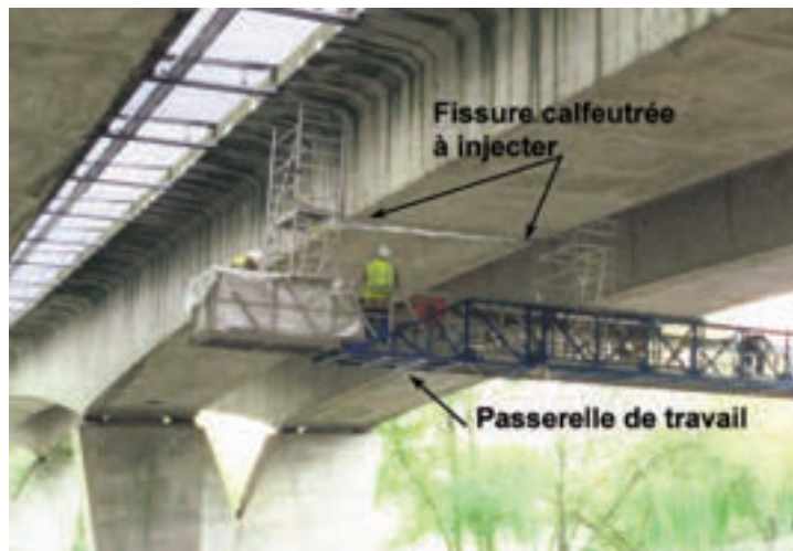
Photo n° 42 : chantier d'injection (crédit photo Parexlanko)
