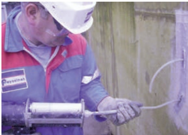
Photo n° 16 : pistolet manuel d'injection (crédit photo Freyssinet)
