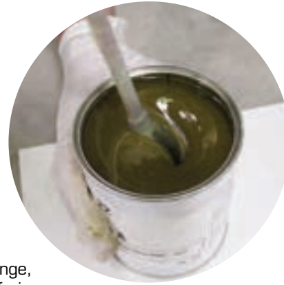
Photo n° 38 : mélange au malaxeur de la résine et du durcisseur (crédit photo Freyssinet)
