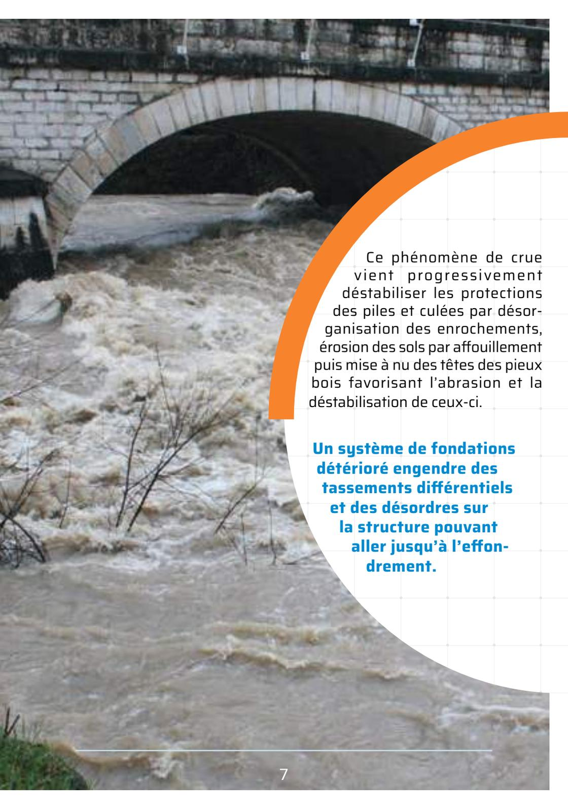
Ce phénomène de crue vient progressivement déstabiliser les protections des piles et culées par désorganisation des enrochements, érosion des sols par affouillement puis mise à nu des têtes des pieux bois favorisant l'abrasion et la déstabilisation de ceux-ci.
