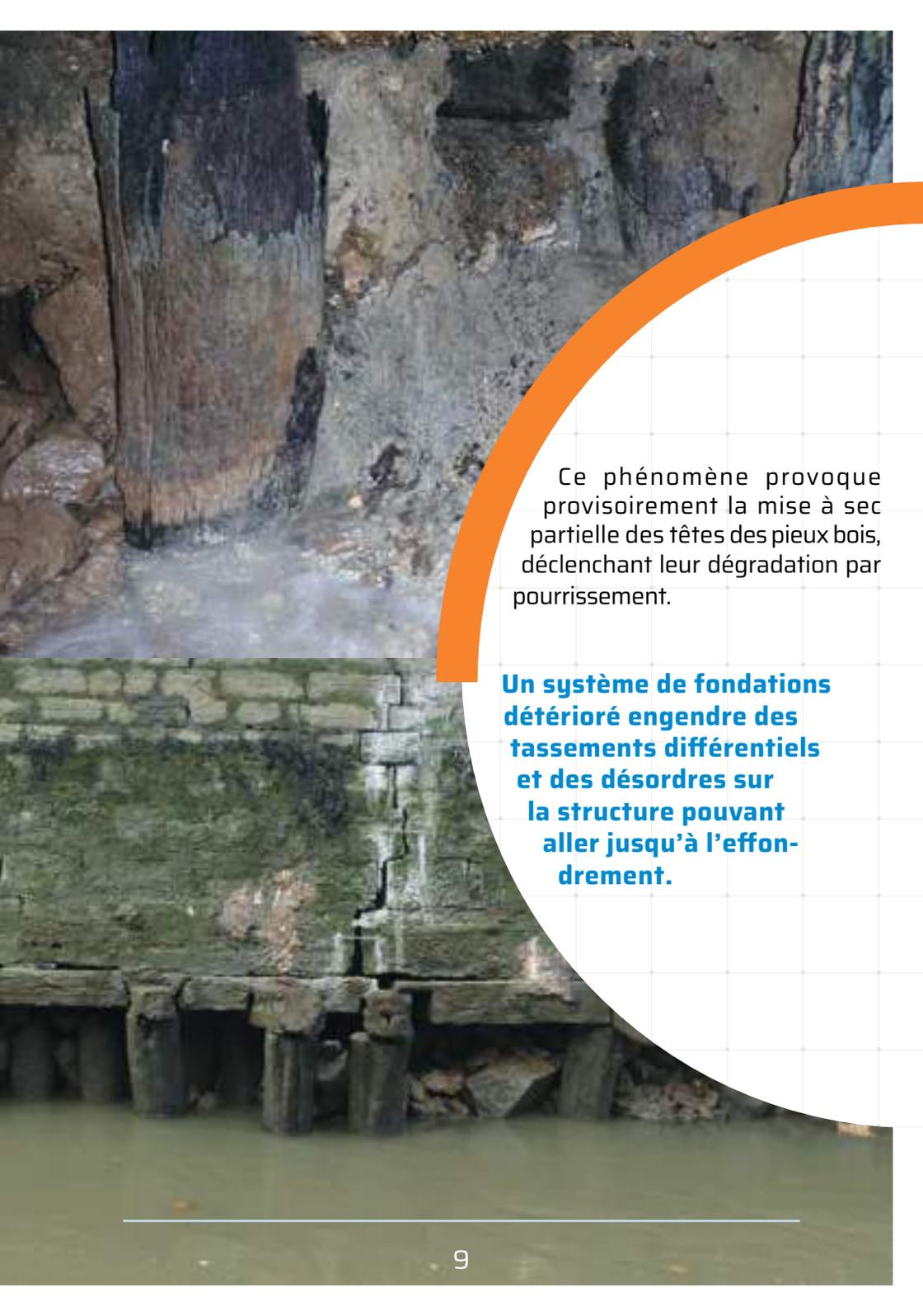
Ce phénomène provoque provisoirement la mise à sec partielle des têtes des pieux bois, déclenchant leur dégradation par pourrissement.
